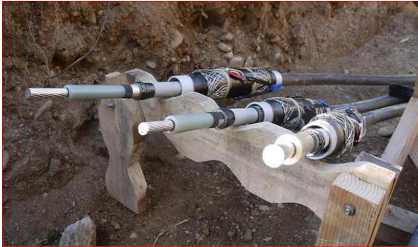
**Fig. I.11** : dénudation des différentes couches du câble [22].
