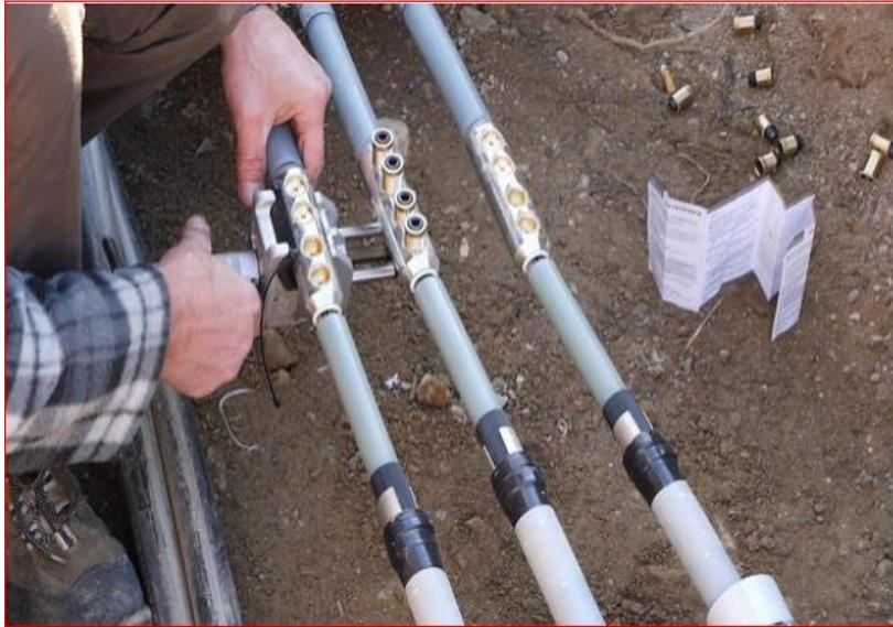
**Fig. I.13** : serrage des connecteurs métallique avec un outil approprié [22].
