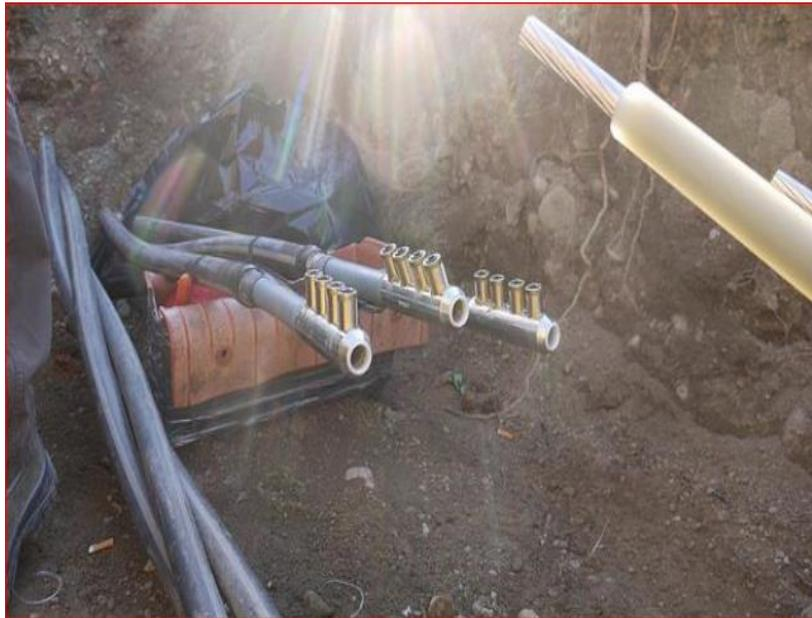
**Fig. I.12** : mise en place des connecteurs métallique sur les conducteurs [22].
