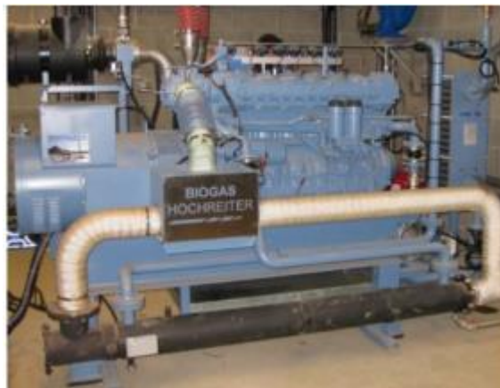
Figure.I.6: Un moteur de cogénération.
