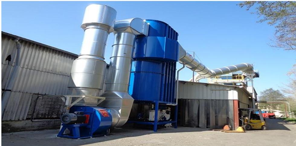
**Figure II.3 :** Mécanisme d'aspiration et de convoyage.[w8]
