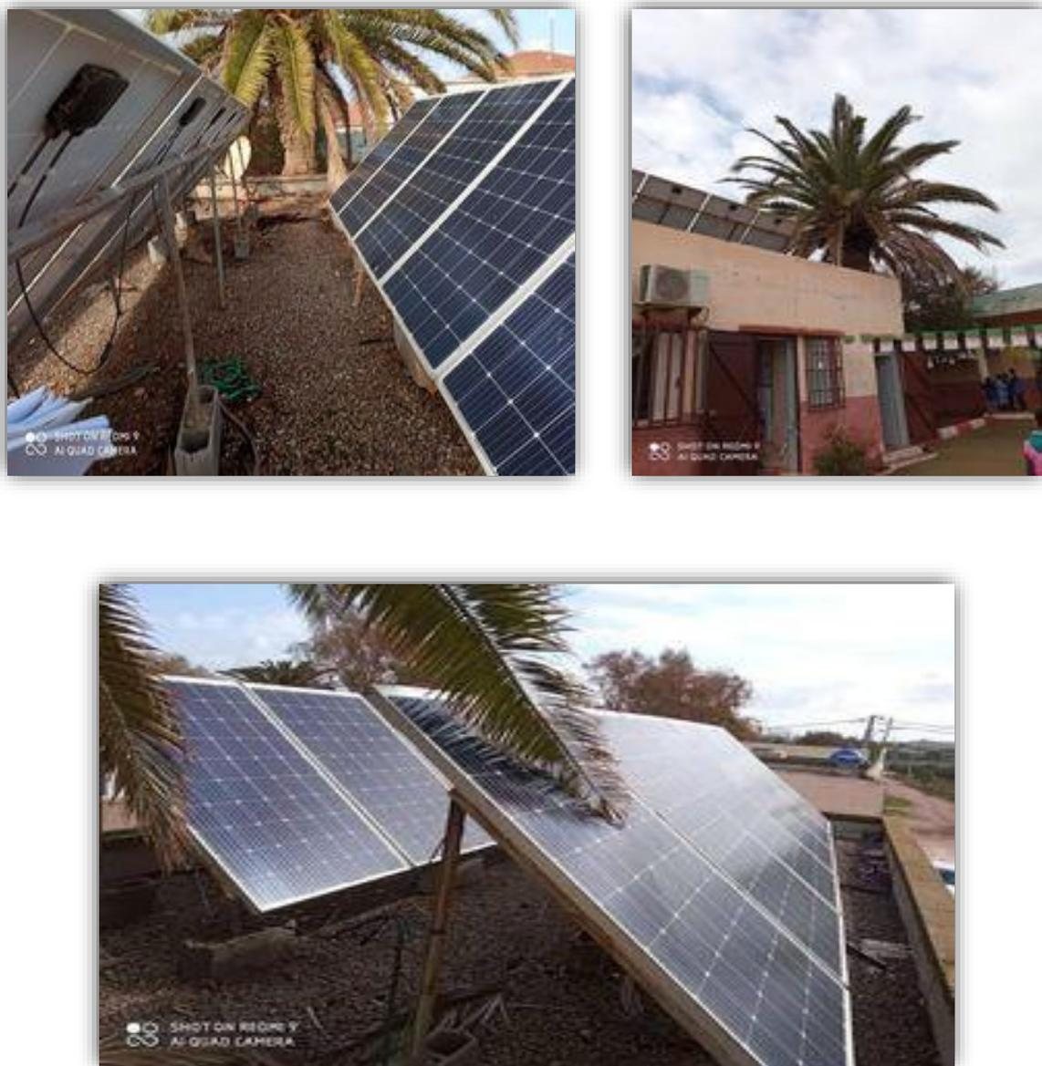
Figure V.7 : Ombrage causé par la distance insuffisante entre les panneaux et la présence du palmier
