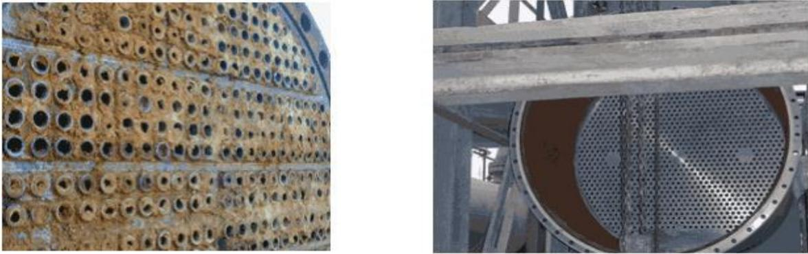
Figure I.32: échangeur sale et propre. [20]
