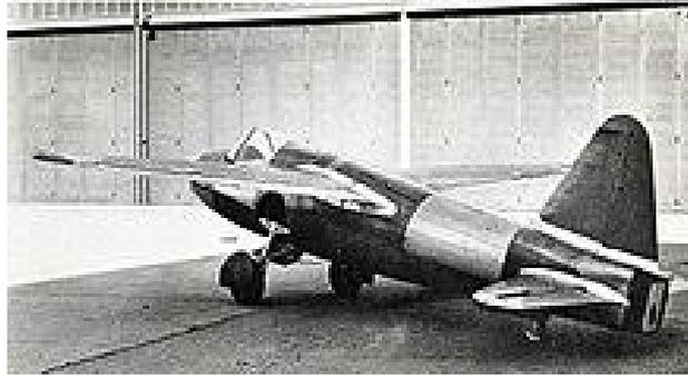
**Figure I.5 :** Le Heinkel He 178, premier aéronef conçu pour être propulsé par un turboréacteur [2]
