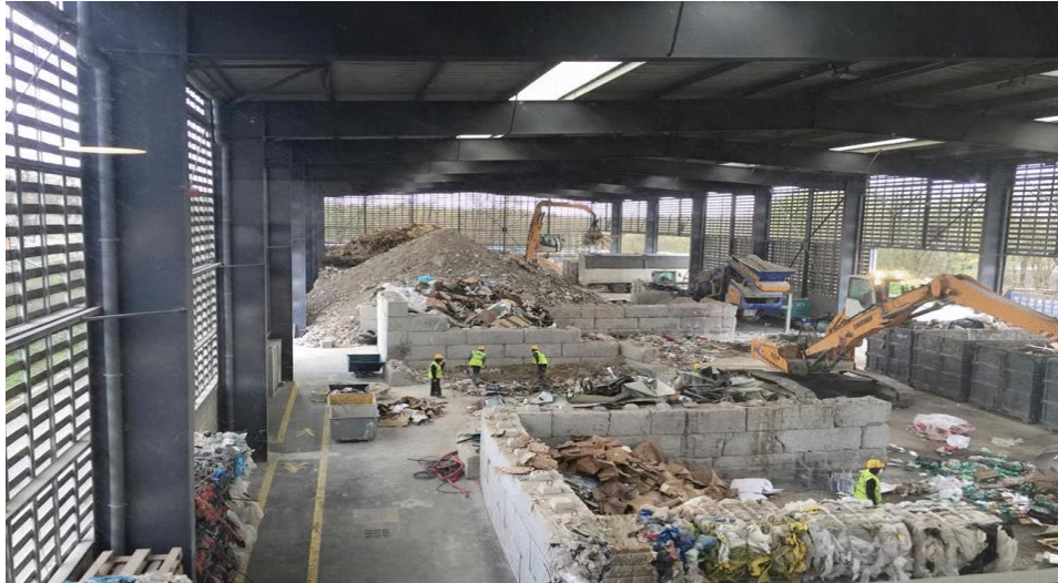
Figure-II- 4: Déchet dangereux sur le chantier
