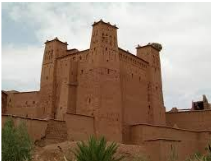
Figure III-4 : Construction avec le pisé [36]
