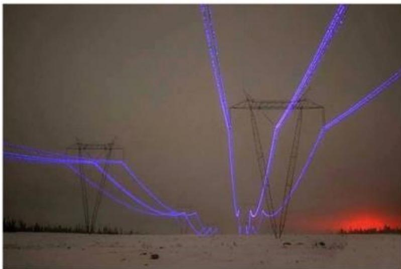
**Figure I-5:** Effet couronne dans les lignes de transmission (735 kV) [31].
