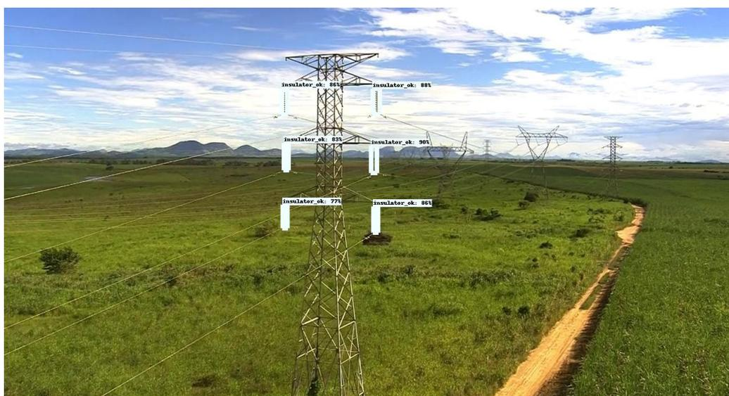
Figure II-28: détection des isolateurs d'un pylône double drapeaux
