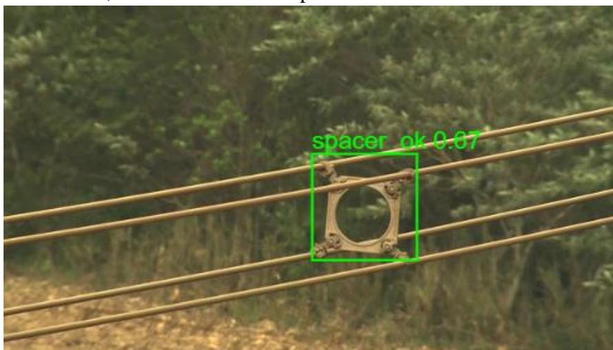
Figure II-20: Détection d'un espaceur
