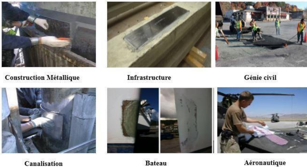
Figure 37: Utilisation la technique de réparation par patch composite
