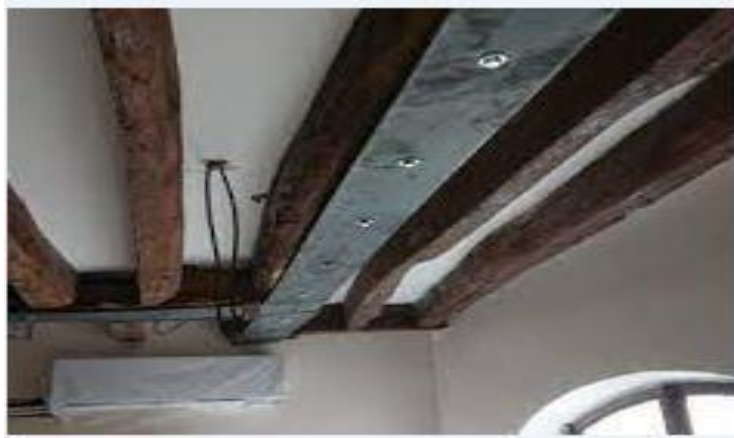
Figure 22 : Illustration du principe de précontrainte avec des boulons HR
