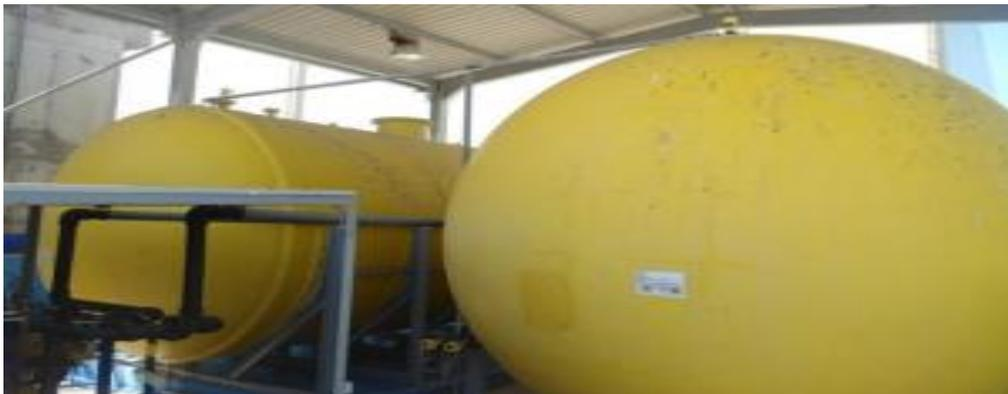
**Figure III. 9:** Réservoir de stockage d'Hypochlorite de sodium. [35]
