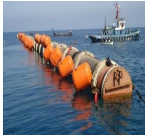
**Figure III.6 :** Lancement de l'émissaire de captage.
