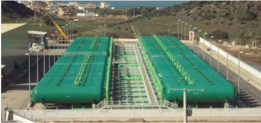
**Figure III. 16 :** Zone des filtres à sable et à anthracite de la SDEM de Béni Saf. [33]
