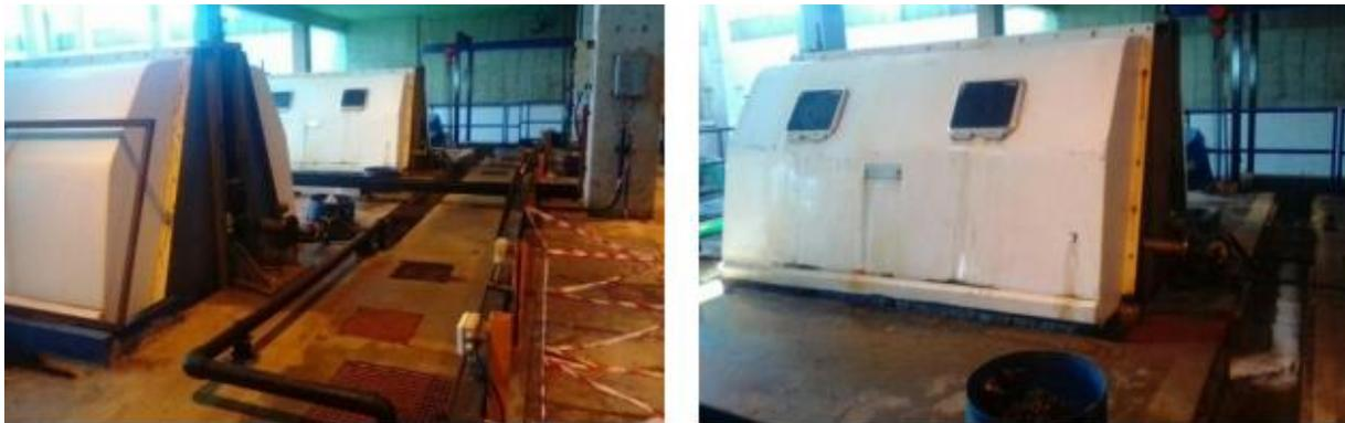
**Figure III. 11 :** Filtres rotatifs de nettoyage. [35]
