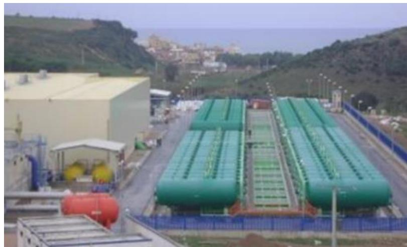
**Figure III. 15:** Zone des filtres à sable et anthracite. [35]
