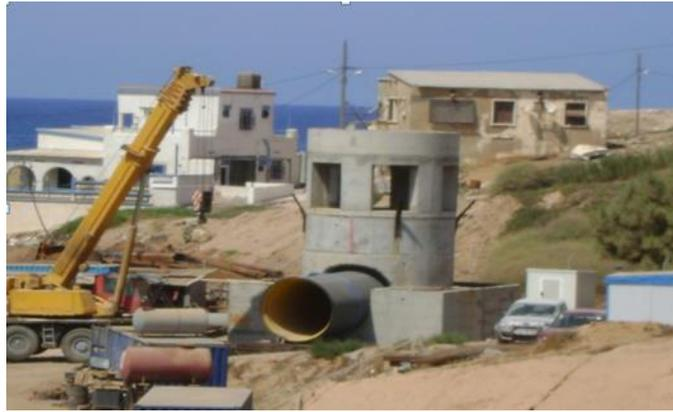
**Figure III.4:** Préfabrication de la tour de Captage. [35]
