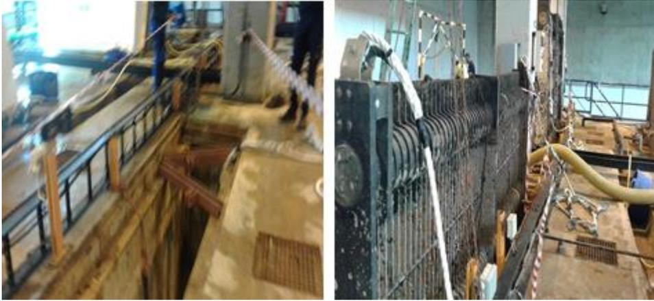
**Figure III. 10:** Le dégrillage pour éliminer les plus gros déchets. [35]
