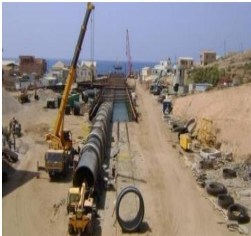
**Figure III.5 :** Préfabrication de l'émissaire DN 2400.
