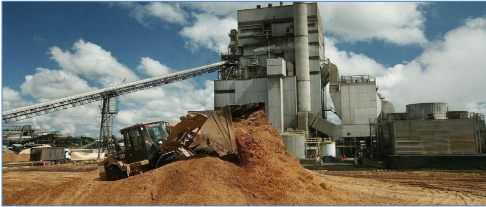
Figure III.2 : Centrale de l'énergie biomasse
