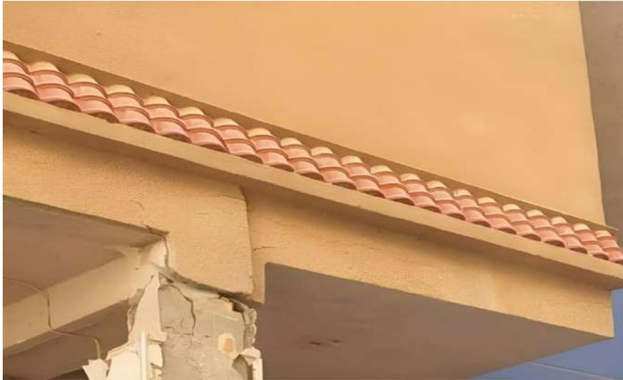
**Photo 32 : Dégradation du béton dans une villa**
