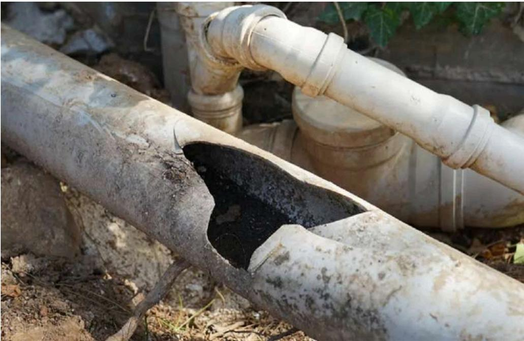
**Photo 44 : Explosion d'un tuyau d'eau dans une maison-patio**
