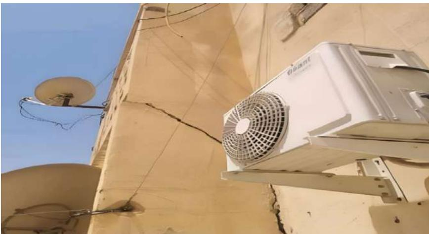
**Photo 35 : Fissure traversent un bâtiment à haï Sidi Saïd**
