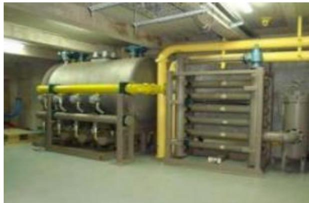
**Figure 1. 20:** Réservoir d'huile et système de refroidissement de l'huile. (Williams et coll., 2001)
