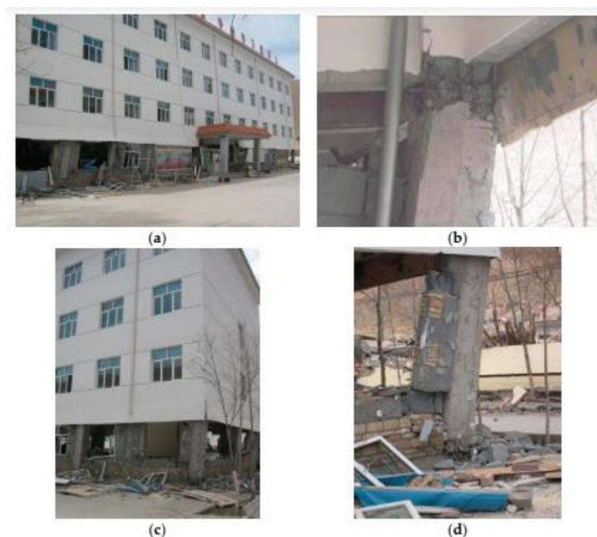
**Figure 2. 11:** Dommages sismiques du bâtiment prototype.
