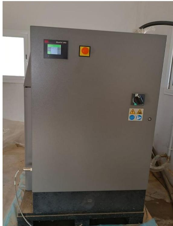
**Figure 1. 26:** Groupe hydraulique (HPU) de la table vibrante de RISAM.
