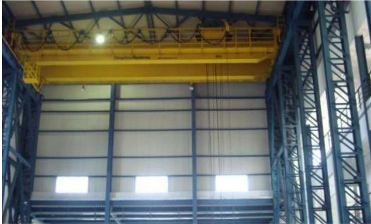
**Figure 1. 22:** Vue sur le pont roulant du laboratoire du CGS. (Williams et coll., 2001)
