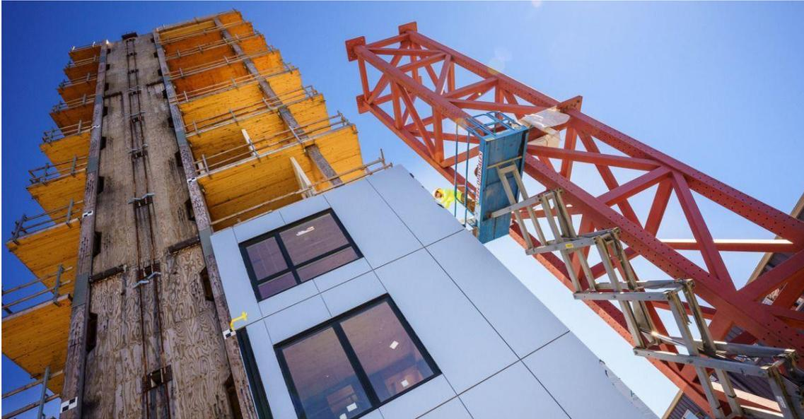
**Figure 2. 1:** Projet Tallwood est un bâtiment de 10 étages en bois lamellé-croisé à échelle réelle. (I. Patringenaru., 2023)
