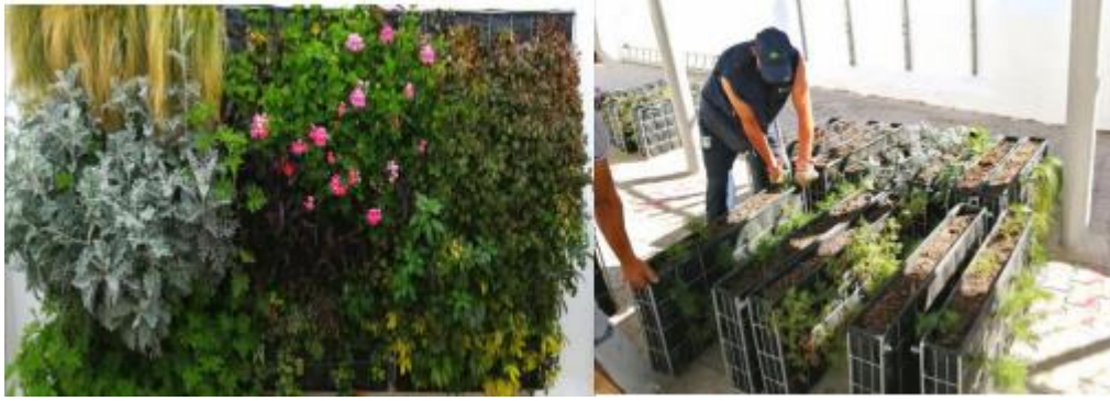
Figure 32: Mise en place des murs végétalisés dans l'école Robert Desnos Tunis, conçu et réalisé par la société SICAP. (EcoVegetal)
