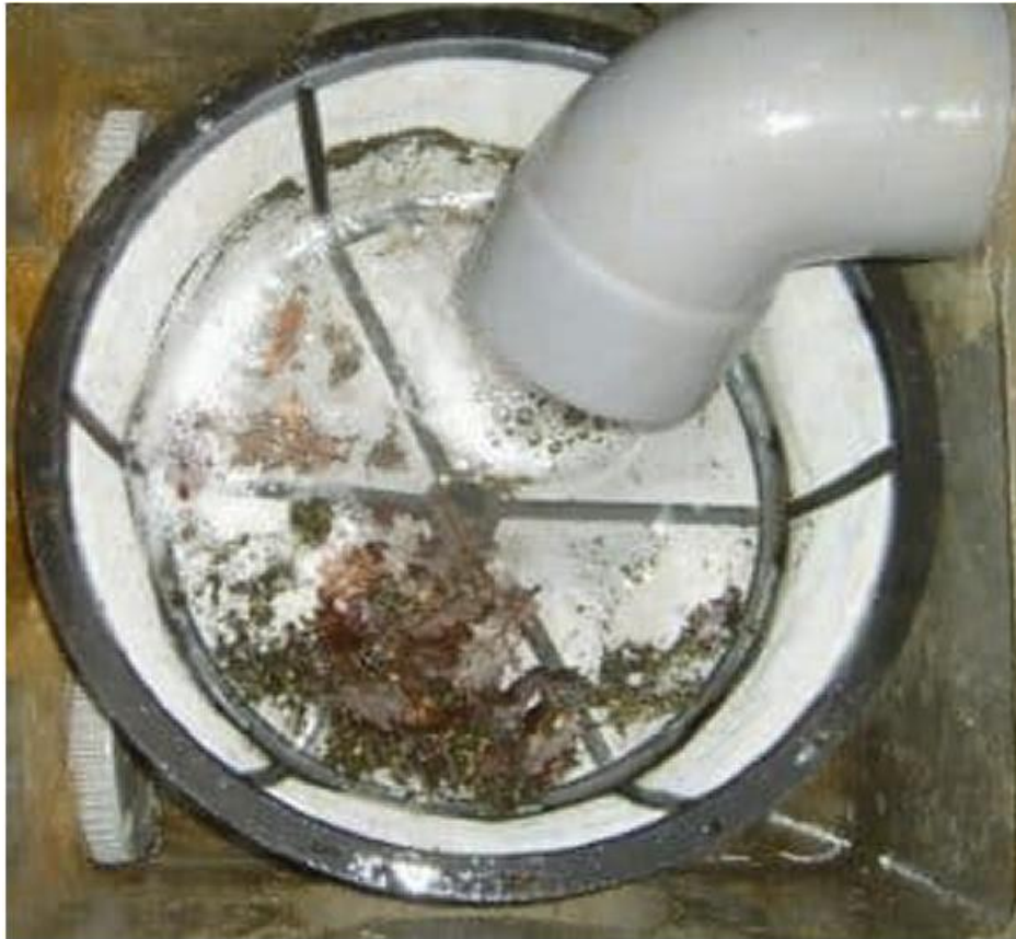
Figure 9: Filtration basique des eaux de pluie.( https://www.adoucisseurdeau.info )
