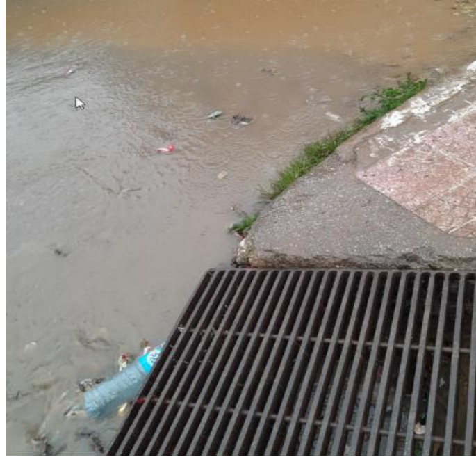
Figure 18: Débordement des égouts.
