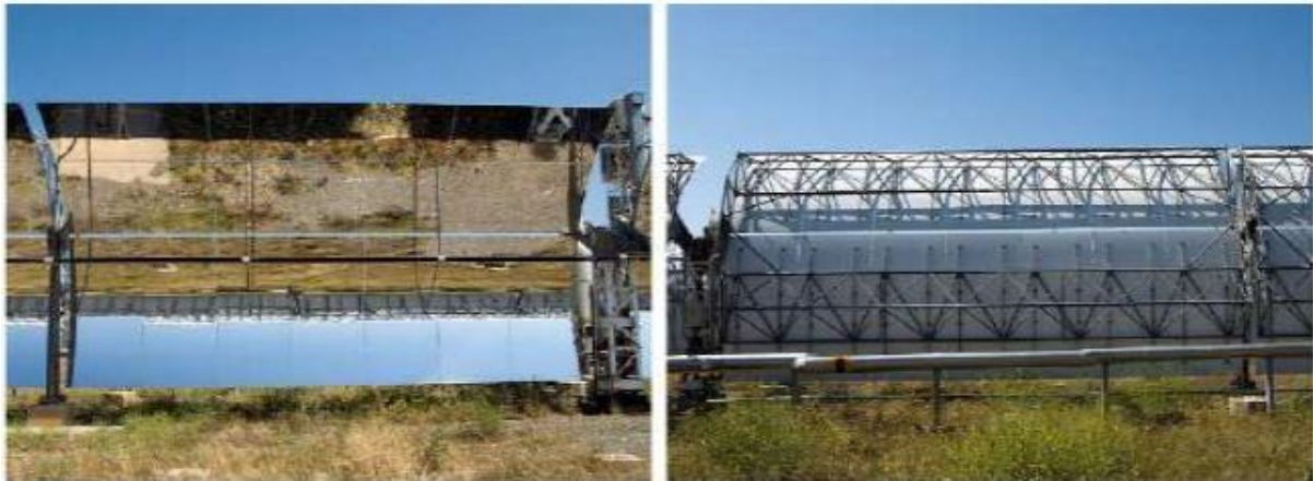
figure I.10: Vue avant et arrière du collecteur LS-3 [24]
