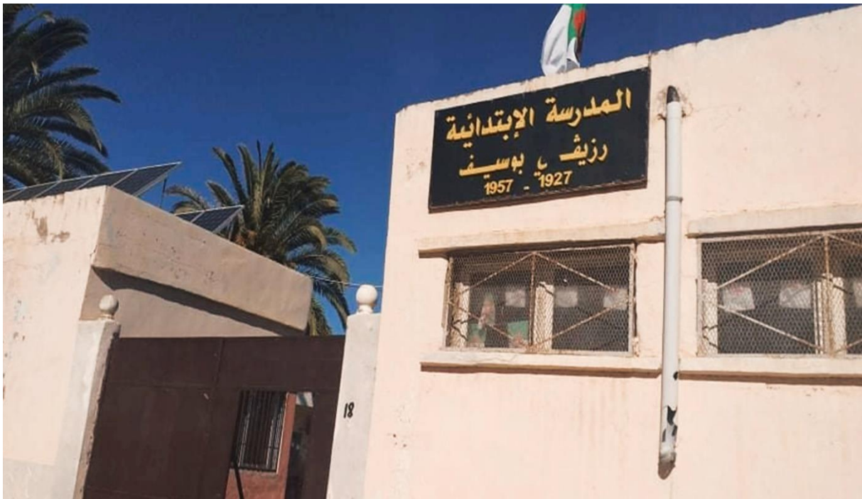
Figure 29: Façade de l'école
