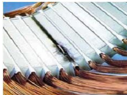
Figure I. 18 : Défaut de court-circuit entre spires
