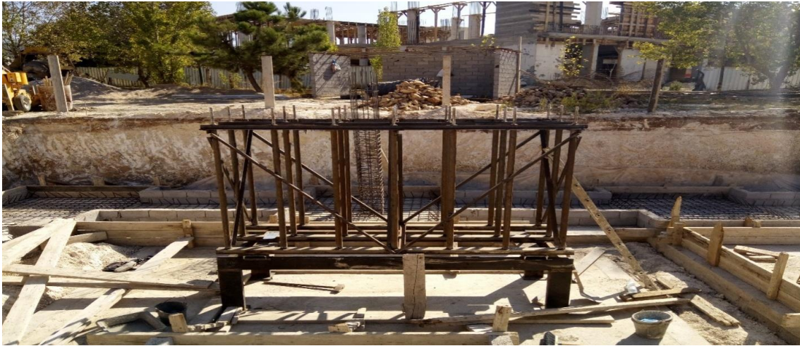
Figure 2.28 : Massif de réaction en pendant la réalisation [33].
