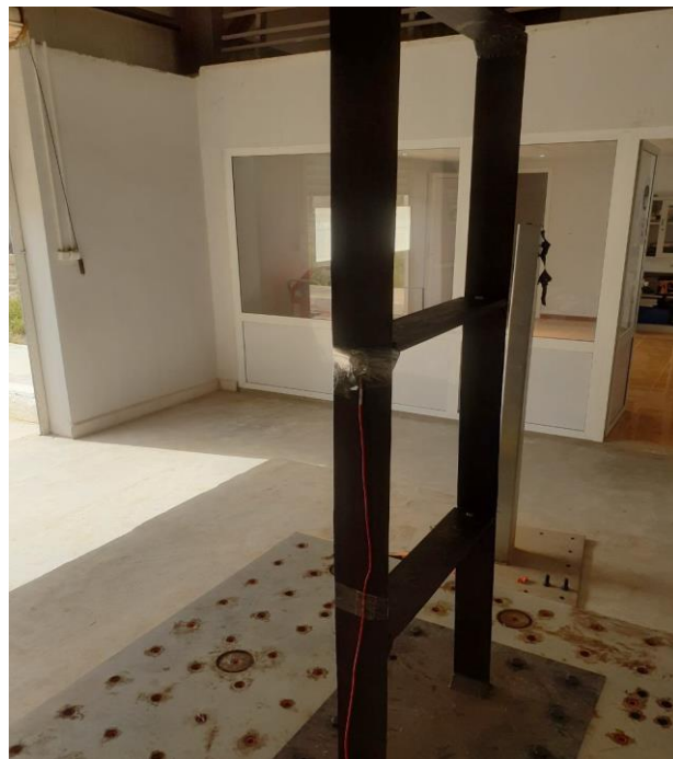
Figure 4.17 : Emplacement de l'accéléromètre au 2 ème niveau.
