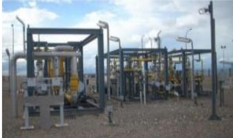
**Figure IV.8 : Système Skid gaz [71].**
