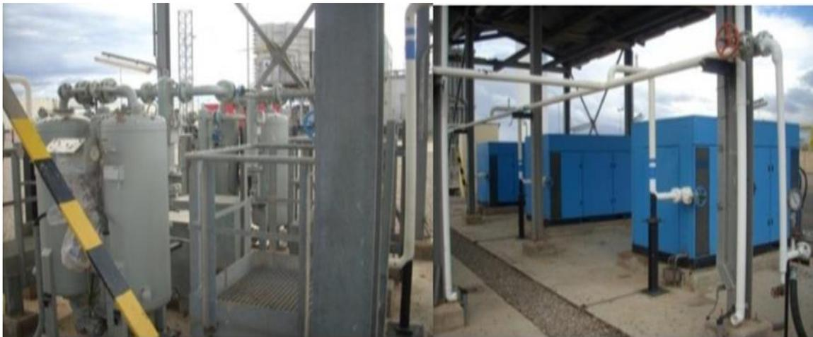
**Figure IV. 5 : Les compresseurs d'air [71]**
