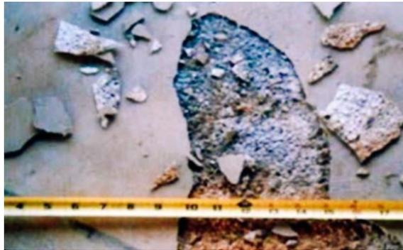
**Figure I.10:** Délamination du béton. [7]
