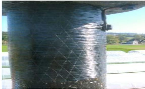
**Figure I.14:** Poteau circulaire en BA confiné par matériaux composites. [10]
