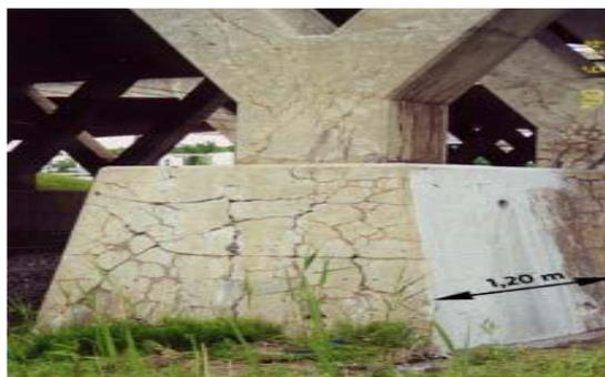
**Figure I.2:** Béton dégradé par Alkali-réaction. [5]
