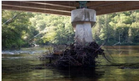
**Figure I.8 :** Abrasion visible sur les fondations du pont. [7]
