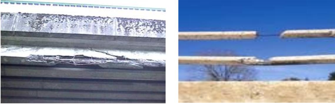
**Figure I.6:** Intrados des ponts dégradés. [4] **Figure I.7:** Barrière de retenue dégradée. [4]
