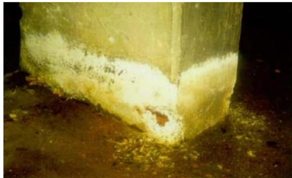
**Figure I.3:** Faiëncage résultant d'une attaque sulfatique. [5]
