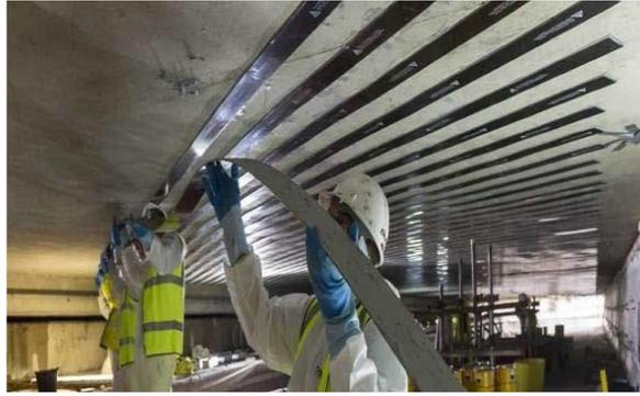
**Figure I.16:** Dalle renforcé par matériaux composites. [10]
