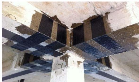
**Figure I.15:** Poutres en BA renforcées par matériaux composites. [10]
