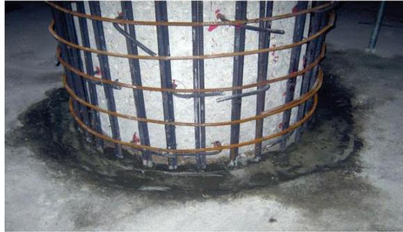
**Figure I.12:** Chemisage en béton armé. [9]
