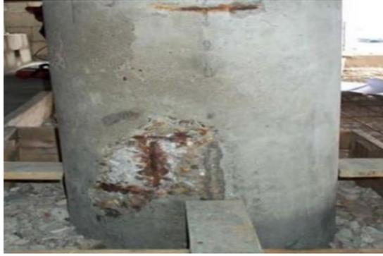
**Figure I.4:** Pile de pont attaqué par la corrosion. [6]
