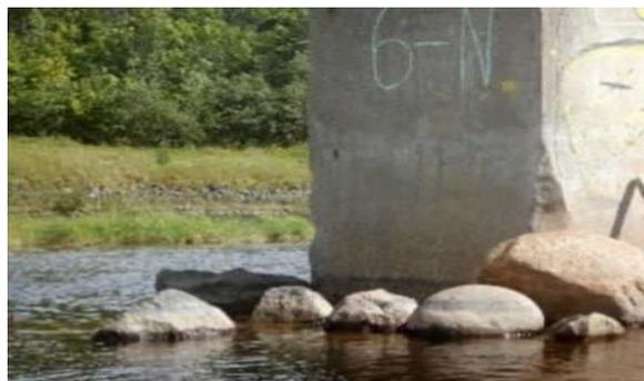
**Figure I.9:** Fissures polygonales et zones d'érosion par abrasion. [7]
