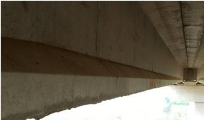
Figure 17: poutre a mis travée
