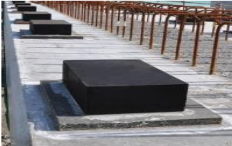
Figure 111: Appareil d'appui en élastomère fretté
