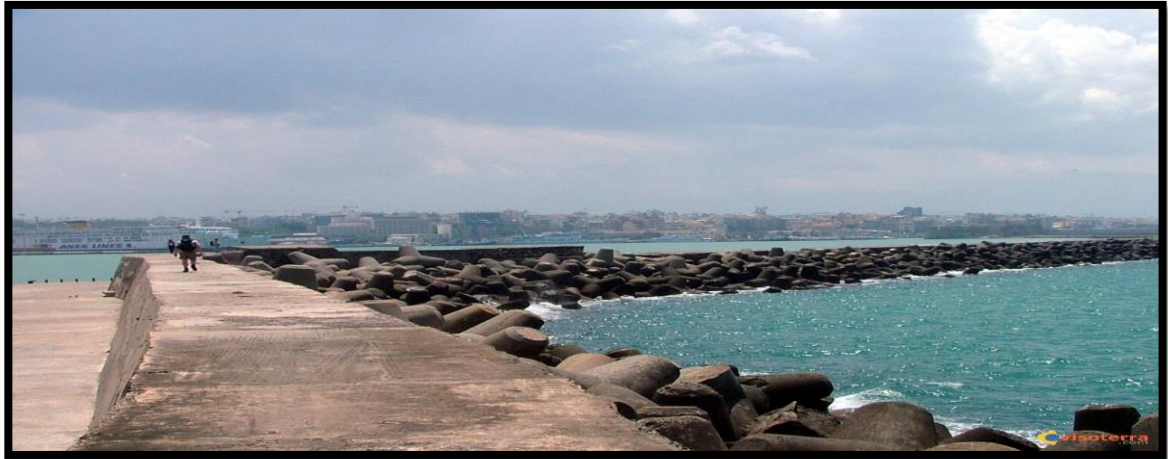
Photo39 : Exemple d'une digue.
