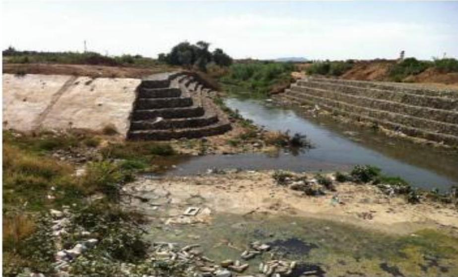
aménagements hydrauliques, les gabions sont fréquemment disposés en épi perpendiculairement à la berge ou parallèlement aux rives pour lutter contre l'érosion fluviale ou torrentielle. Des seuils ou petits barrages peuvent être également réalisés. [45]
