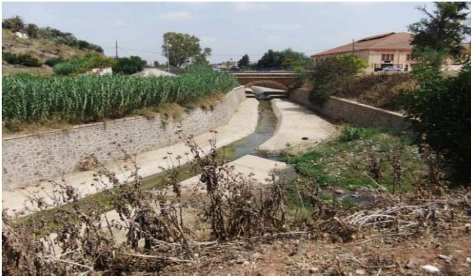
**Figure 63: Canalisation du chenal de basses eaux et pont sur le cours d'eau Sennane.**
