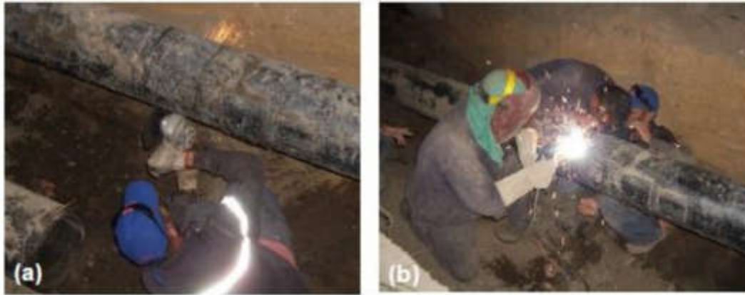
Figure II.10 : Changement de tronçon endommagé d'une canalisation, (a) découpe, (b) résoudage [27]
