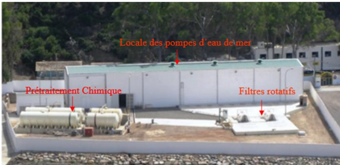
Fig. II.7. Vue de la zone de captation et pompage. [05]
