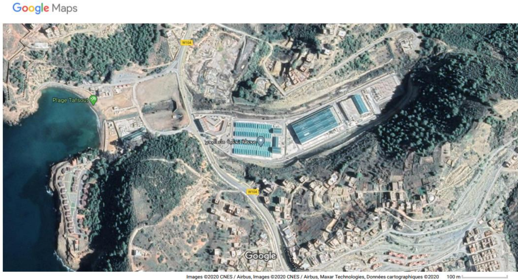
Fig. II.4. Vue satellite de la station de Honaine. [W15]
