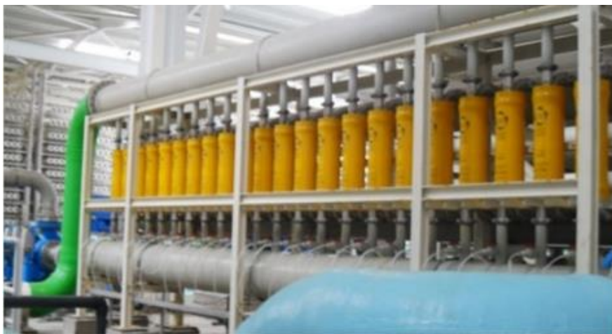
Fig. II.24. Installation des échangeurs de pression. [05]
