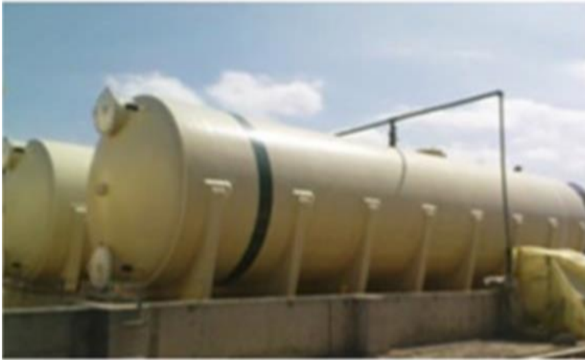
Fig. II.13. Les réservoirs d'Hypochlorite de sodium.[05]
