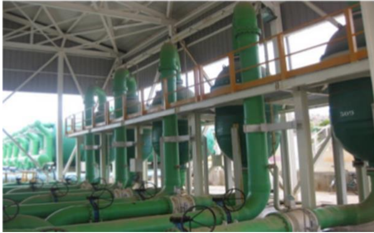
Fig. II.16. Les filtres à cartouches.[05]
