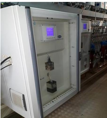
L'analyseur de la silice sous marque HACH, ce dernier contient un photomètre équipé par des réactifs installé sur l'appareil lui-même. Il fait les analyses périodiques pour chaque échantillon et affiche les résultats obtenus au niveau de la salle de commande principale.
