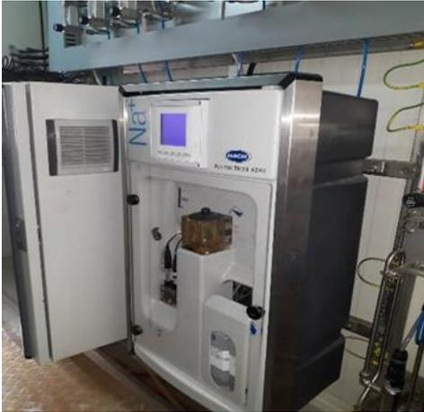
Un analyseur de sodium c'est un appareil qui vérifie que l'eau n'est pas contaminée par du sodium en utilisant une électrode de sodium et équipée avec réactif d'analyse. L'appareil affiche les résultats sur la salle commande principale
