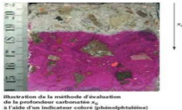
Fig.II-2 : mesure de la profondeur de la carbonatation. [10]
