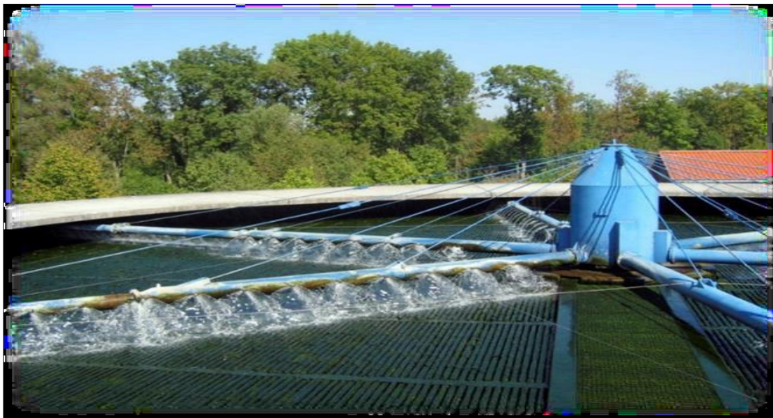
Figure I.12 : Exemple d'une station à lit bactérien
