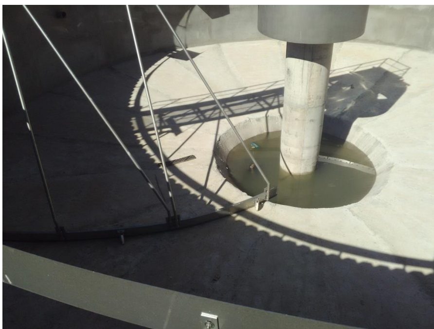
Figure IV.7: Décanteur secondaire «clarificateur» en cour de réalisation
