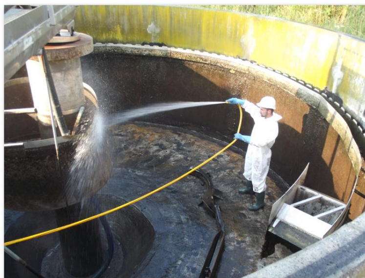
Figure V.1 : L'entretien d'un bassin d'une station d'épuration
