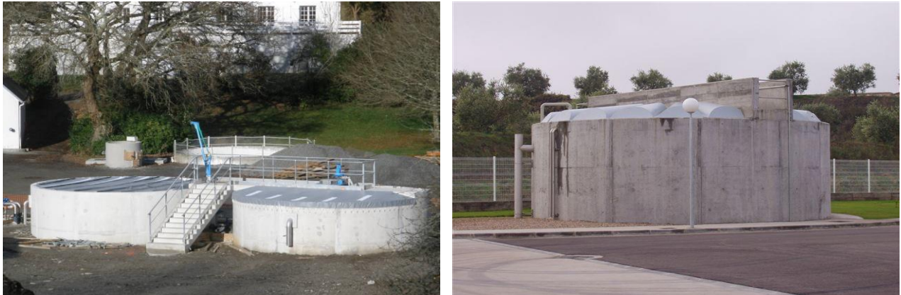
Figure IV.10 : Les ouvrages de l'épaissement
