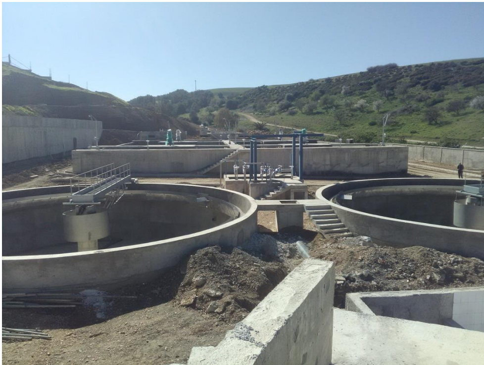
Figure IV.9 : les deux clarificateur en cours de réalisation
