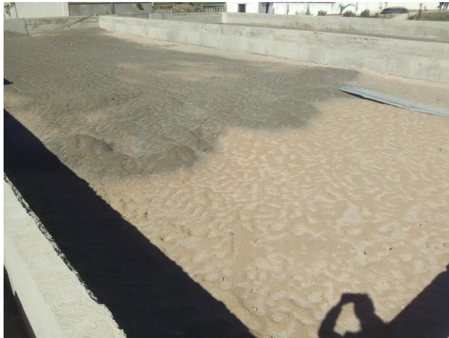
Figure IV.11 : Les lits de séchages en cour de réalisation
