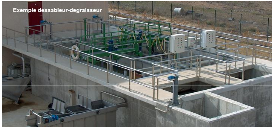
Figure IV.5 : Exemple dessableur-dégraisseur
