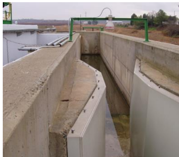
Figure IV.12 : Système de contrôle du débit des eaux traitées
