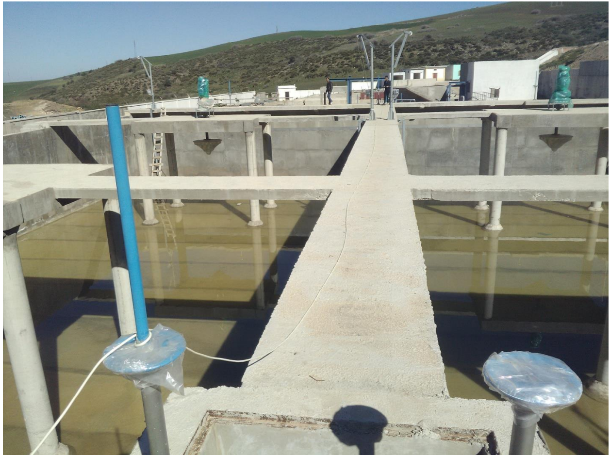
Figure IV.8 : Le bassin d'aération en cours de réalisation
