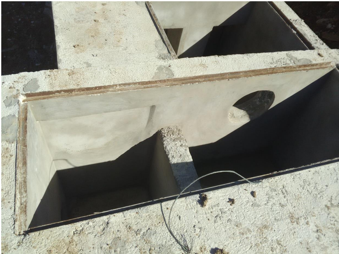
Figure IV.2 : La chambre de réception en cours de réalisation
