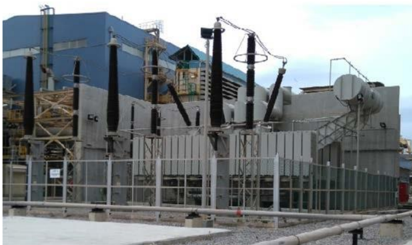
Figure I.8 : Transformateurs élévateurs.
