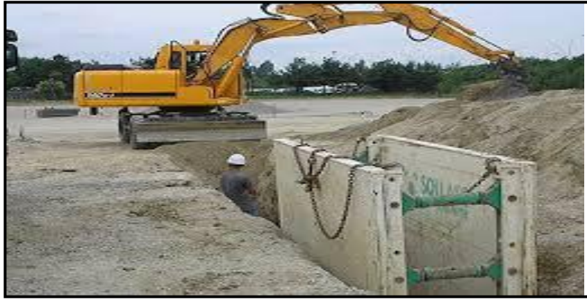
Figure IV.3 Sécurité contre l'effondrement
