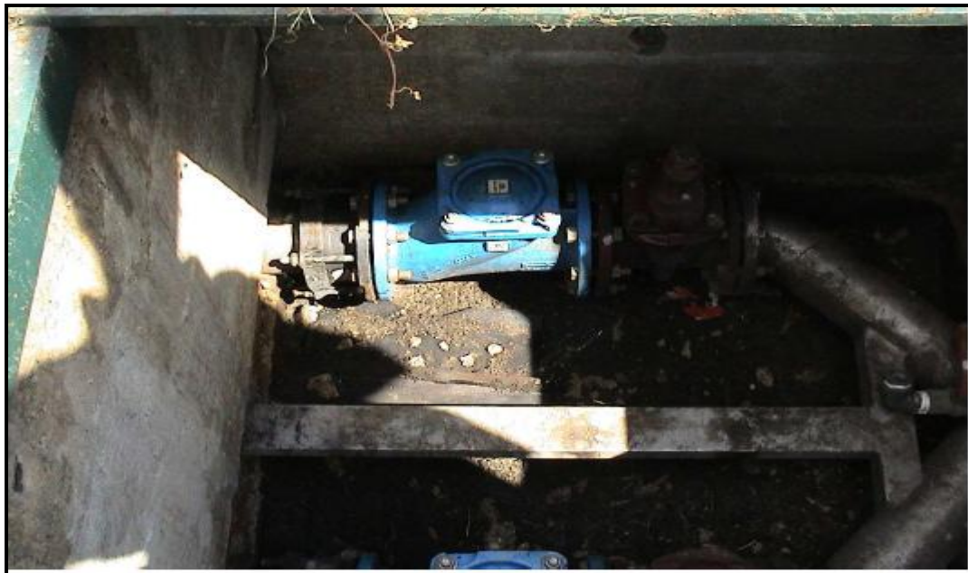
Figure III.11 Schéma de montage d'un clapet anti retour
