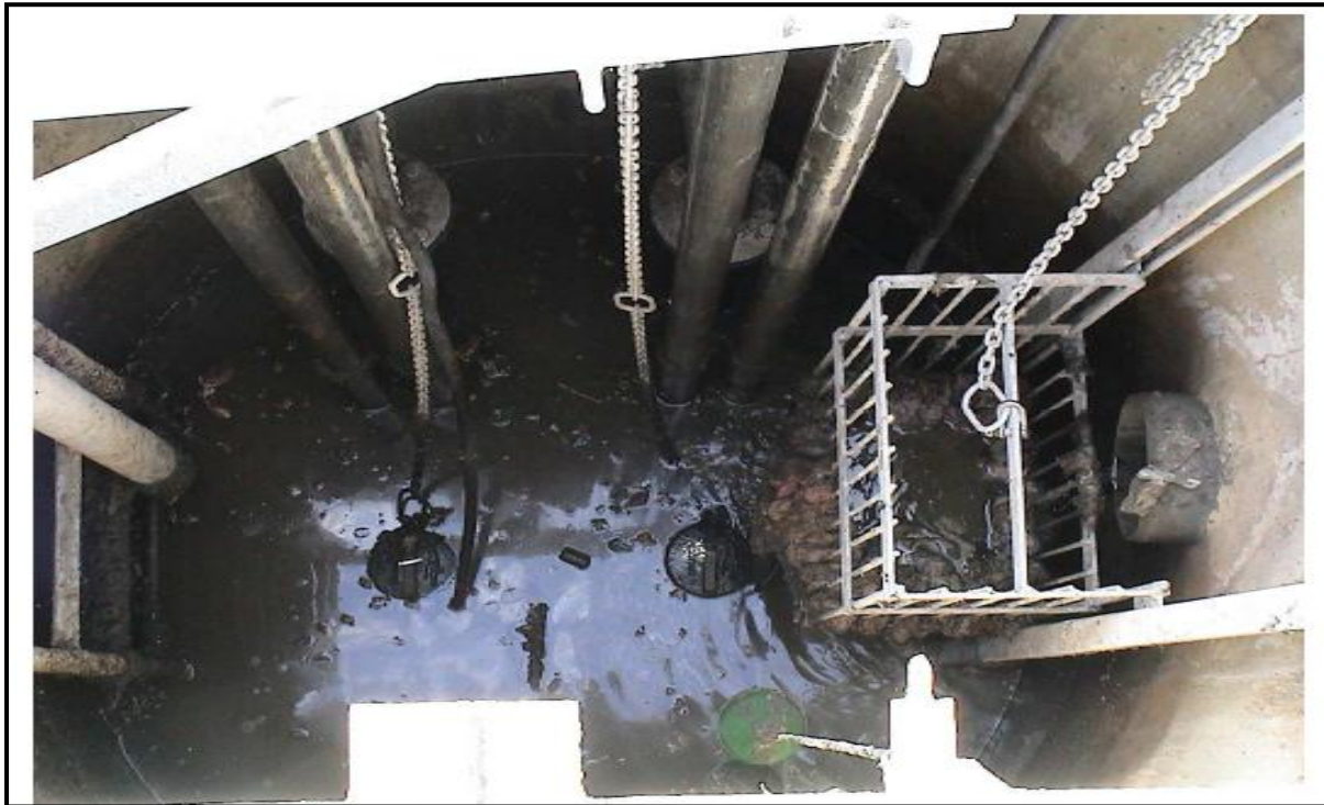
Figure III. 8 Panier dégrilleur
