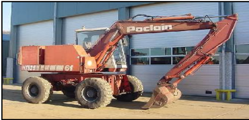
Figure IV.6: Pelle équipée en rétro
