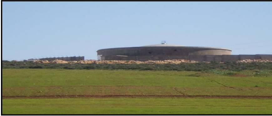
Figure I.16 Réservoir du centre d'Ain Larbaa de 5000 m 3 en cour d'exécution
