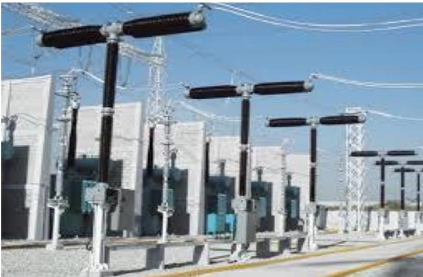
Figure III-2 : Disjoncteur à haute tension [18].
