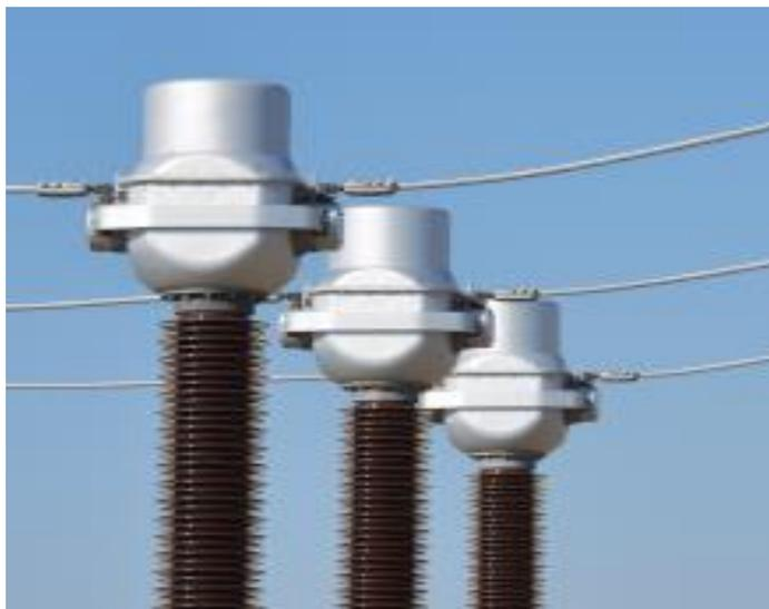
**Figure III-3 : Transformateur de courant [19].**
