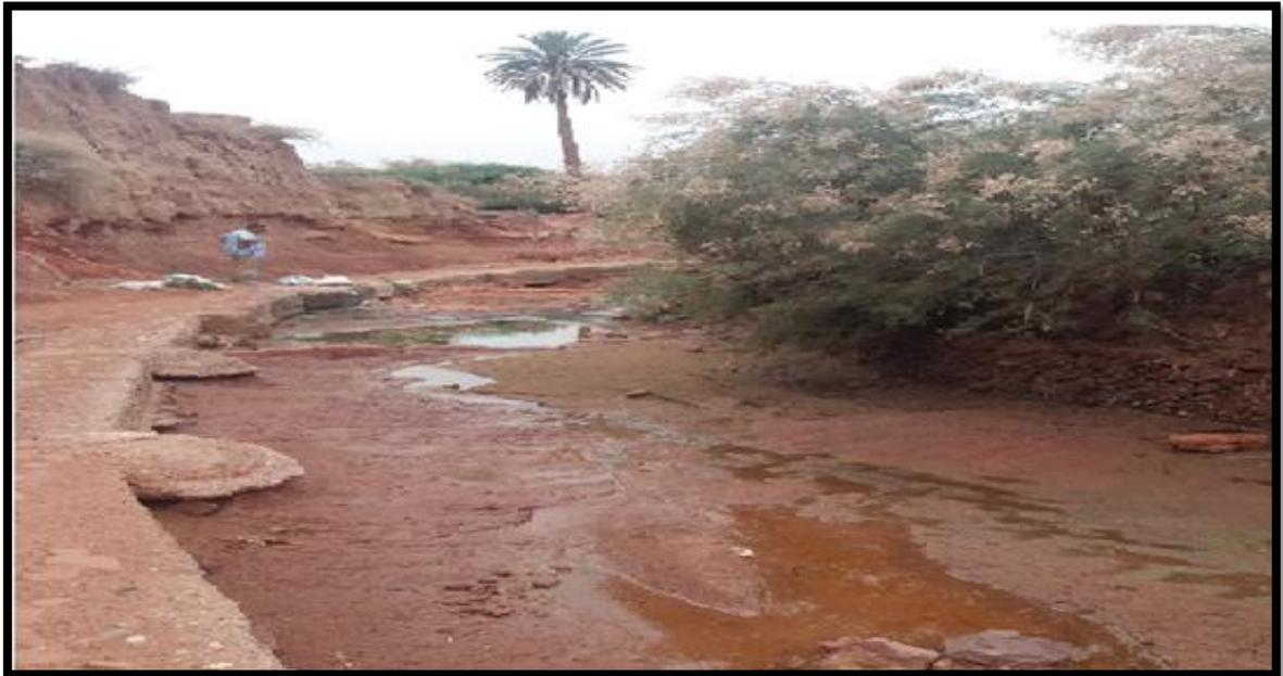
**Figure III.1** :le passage du collecteur TIOUT MATLAAG sur chaabat el hamra pour rejoindre le rejet principal de la ville les affouillements et la diversement flagrant des eaux usées du a la détérioration du collecteur
