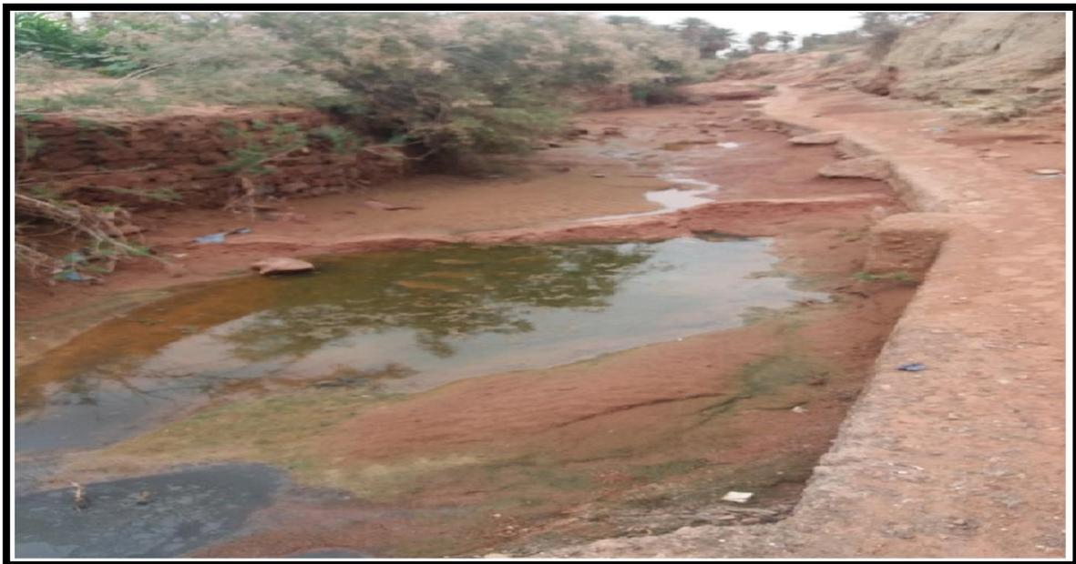
**Figure III.2** : Le passage du collecteur TIOUT MATLAAG sur CHAABAT EL HAMRA et les traces d'instabilité le long de son parcours jusqu'au point de confluence
