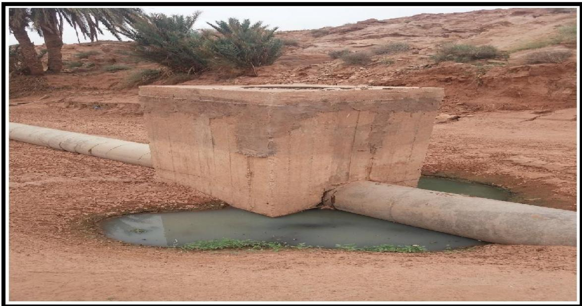
**Figure III.8 :** Collecteur de rejet principal de la commune de TIOUT déterré et renversé par l'effet du transport solide dû à la vulnérabilité du terrain
