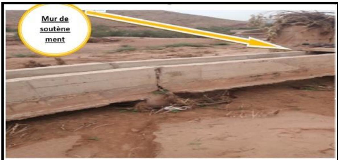
**Figure III.6 :** Renversement et dégradation Dû à l'affouillement au-dessous du canal en béton armé du collecteur de rejet de TIOU au niveau de son passage au bord d'oued TIOU
