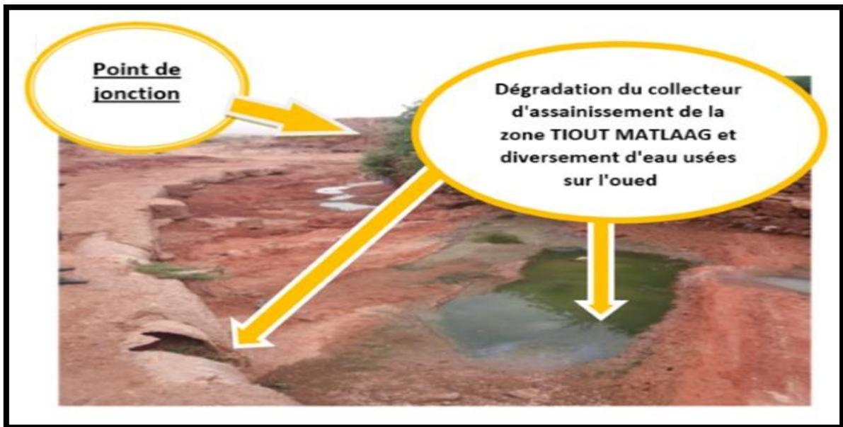
**Figure III.3 :** Le passage du collecteur TIOUT MATLAAG sur CHAABAT EL HAMRA et les traces d'instabilité le long de son parcours jusqu'au point de confluence
