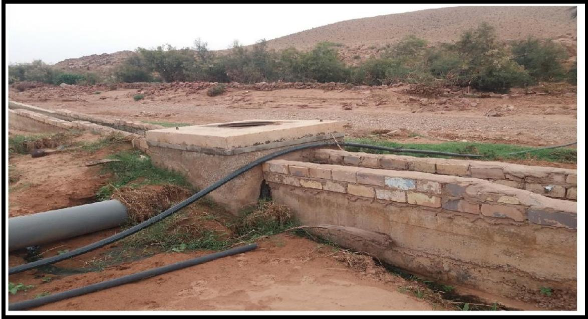
**Figure III.7 :** Renversement et dégradation Dû à l'affouillement au-dessous du canal en béton armé du collecteur de rejet de TIOUT au niveau de son passage au bord d'oued TIOUT
