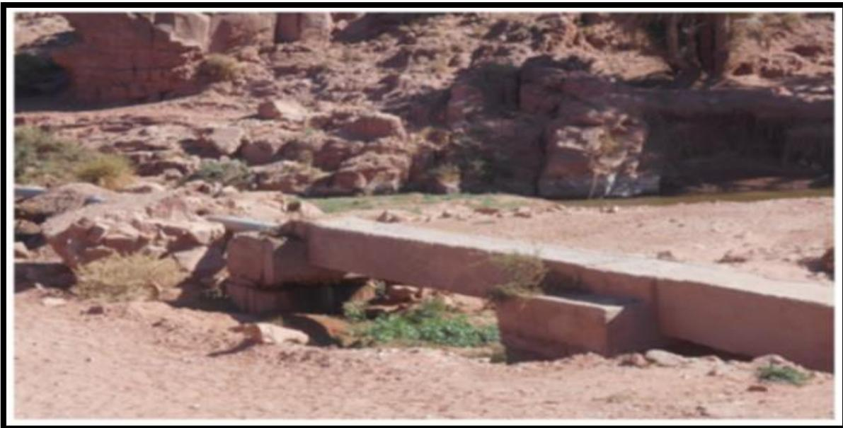
**Figure III.4 :** Le passage du collecteur TIOUT MATLAAG sur CHAABAT EL HAMRA et les traces d'instabilité le long de son parcours jusqu'au point de confluence
