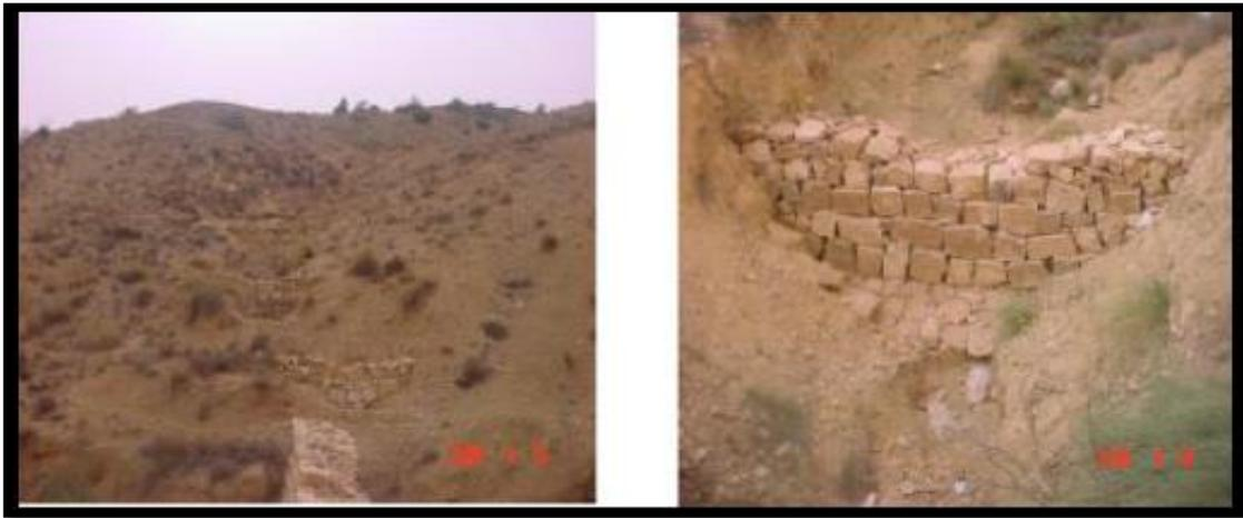
Figure IV.3 : Correction torrentielle
