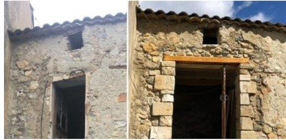
**Photo.31** Création ouverture maçonnerie sur mur porteur pour porte fenêtre
