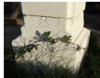
**Photo.32** Base de pilier vieille pierre (technique du moule en bois).
