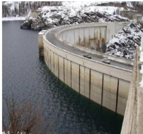
Figure 5 : Barrage type voûte
