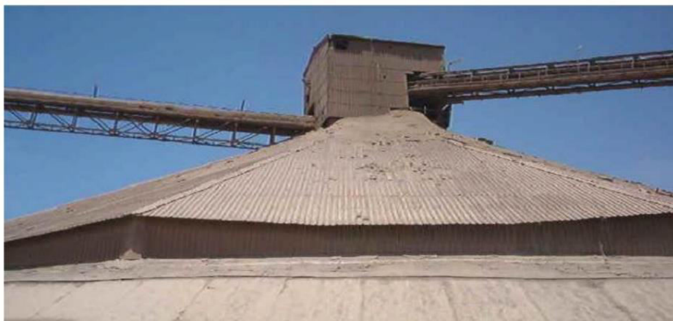
Figure : I.B.8 Bulle de stockage du clinker [21]
