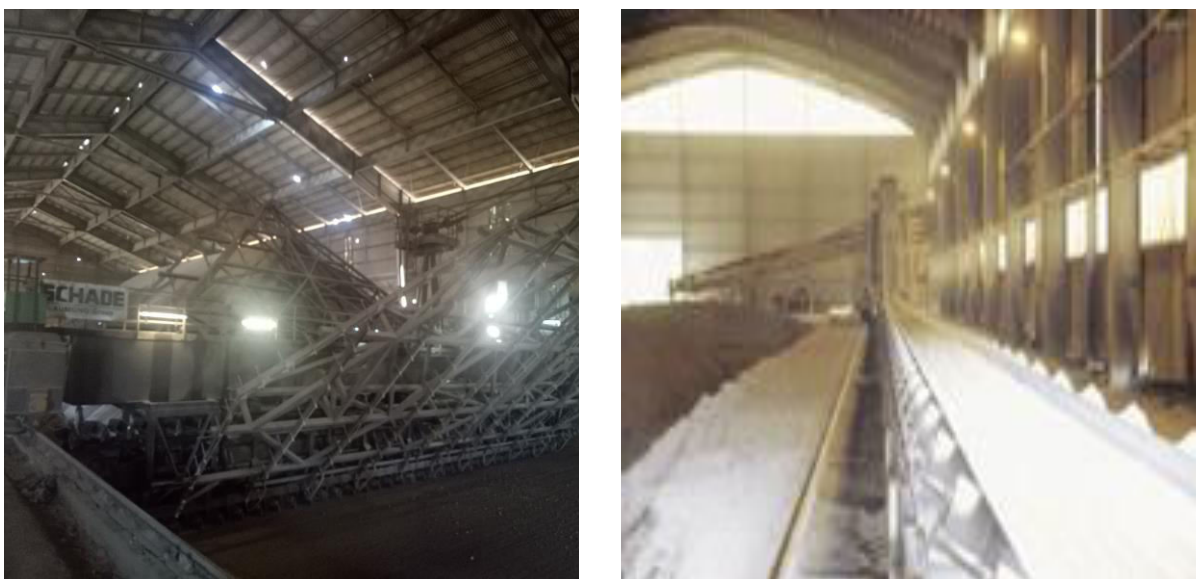
Figure I.B.3 Hall de Pré Homogénéisation [21]
