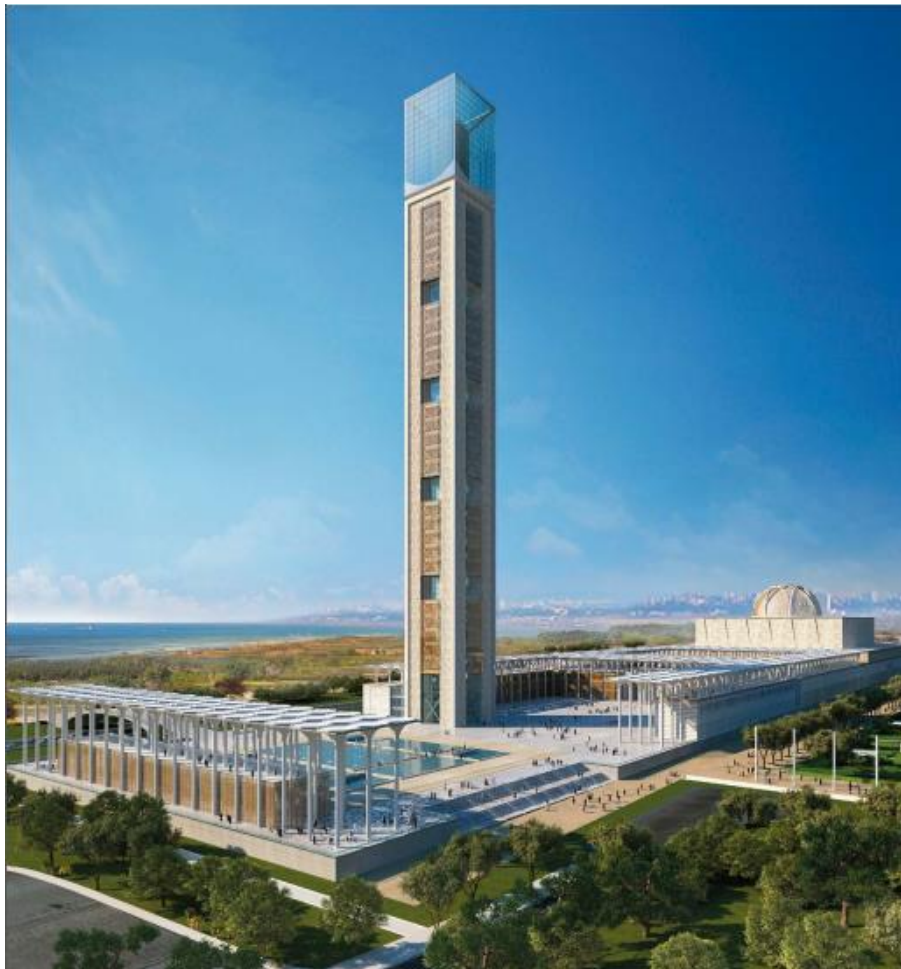
Figure V-2 : Vue générale de la grande mosquée.
