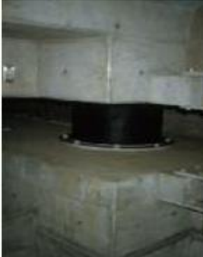
Figure IV-13: Constructions isolées à la base.
