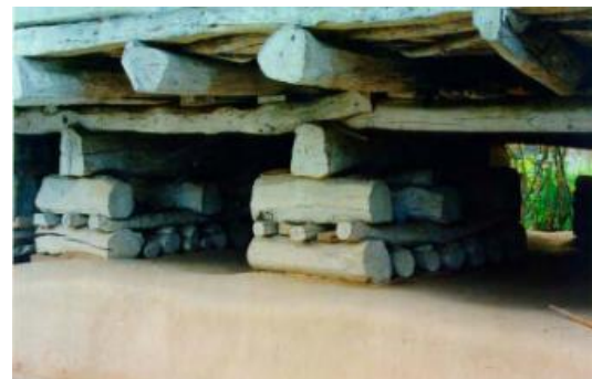
Figure IV-7 : Maison typique : l'utilisation des morceaux de bois entre le sol et la fondation En France.
