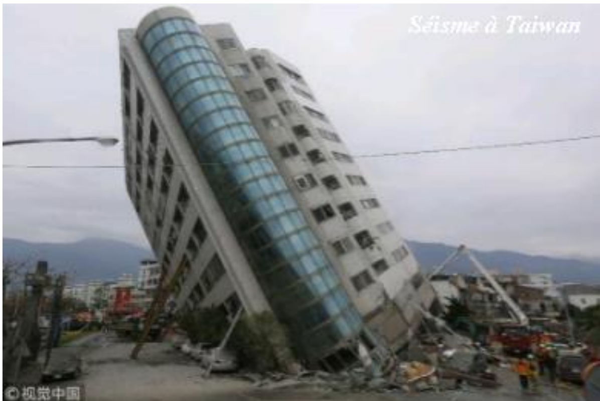
Figure I-22 : Hôtel à Taiwan après le séisme du 7 Février , 2018.
