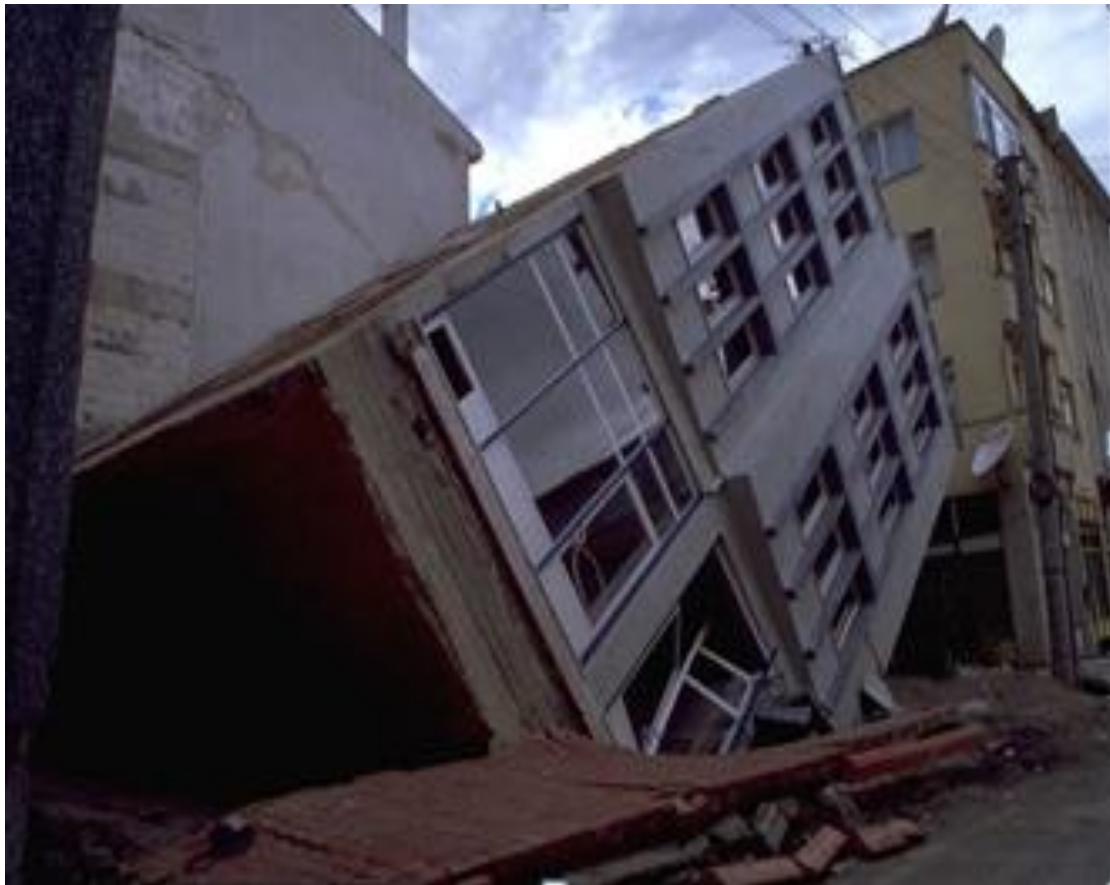
Figure I-4 : Phénomène de liquéfaction de sol causé par le séisme d'Izmit, Turquie 1999.
