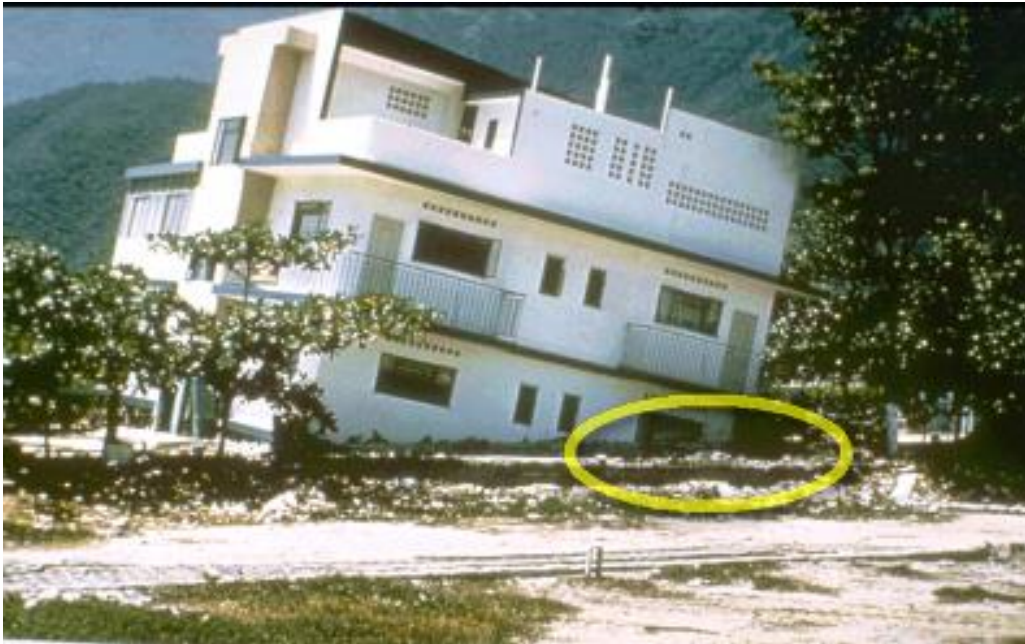
Figure I-5 : Séisme de Caracas, 1967(Enfoncement d'un bâtiment dans le sol sous l'effet d'un tassement localisé dû au phénomène de liquéfaction du sol d'implantation), Document USG
