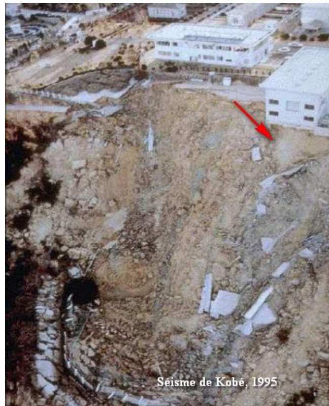
Figure I-9 : Glissement de terrain ayant entraîné la perte totale d'un bâtiment « parasismique » situé en bord de talus instable. (Document NISEE -USA).
