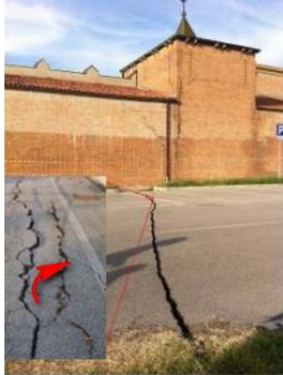
Figure I-7 : Effet de la liquéfaction des sols (Séisme d'Emilie-Romagne, mission AFPS).
