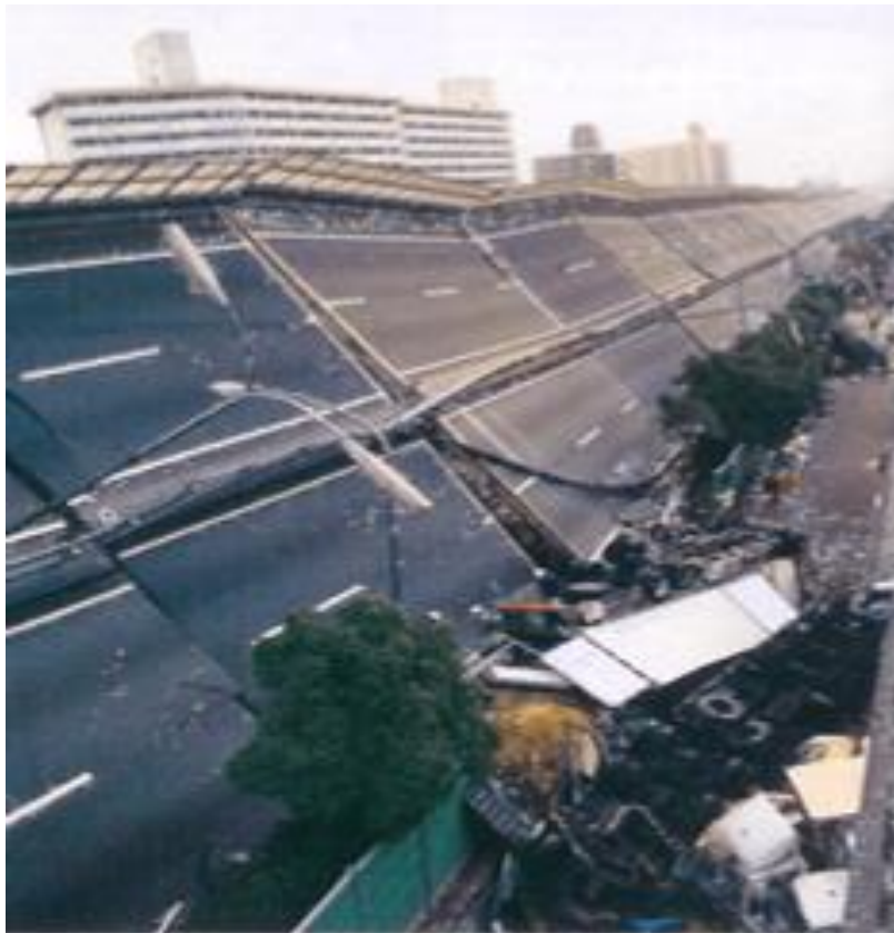
Figure I-15 : séisme à Kobé au Japon (1995)
