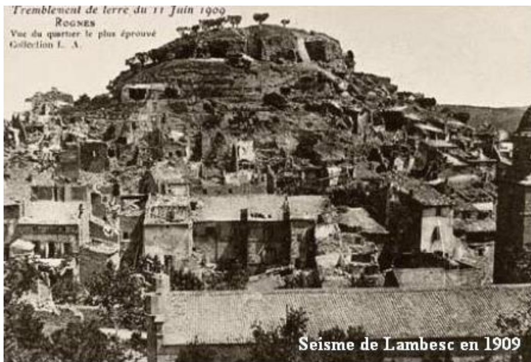
Figure I-11 : Dévastation des constructions situées sur la butte de Rognes causé par l'effet de site.
