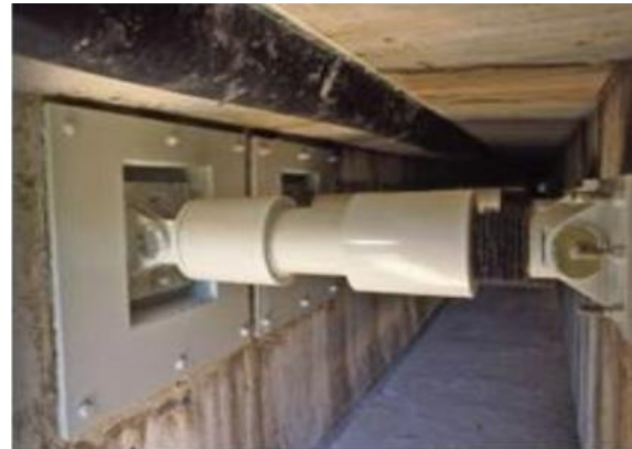
Figure IV-25 : Amortisseur visqueux
