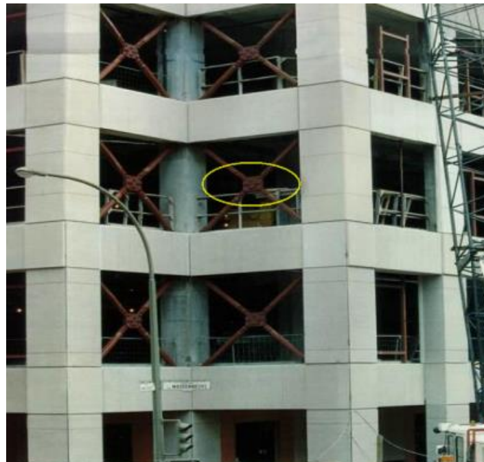
Figure IV-26 : Amortisseur à frottement à l'université de Concordia, Montréal.
