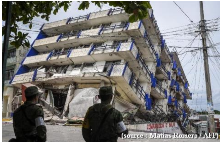
Figure I-20 : Immeuble affaissé après le séisme du 8 septembre 2017.
