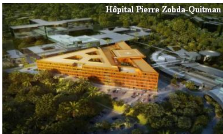
Figure IV-8 : Hôpital Pierre Zobda-Quitman sur des appuis parasismique.
