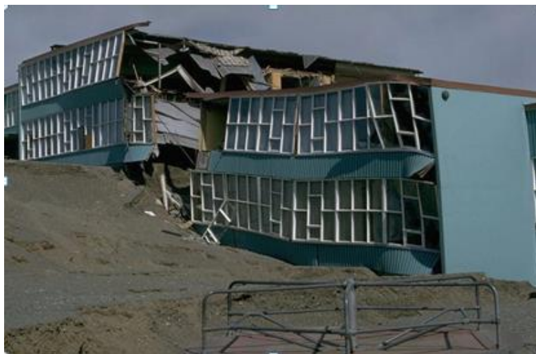
Figure I-8 : Phénomène de glissement de terrain (séisme d'Alaska, USA 1964).
