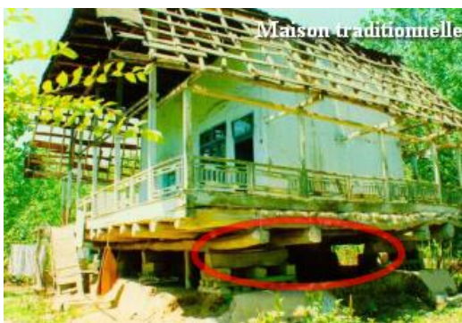
Figure IV-7 : Maison typique : l'utilisation des morceaux de bois entre le sol et la fondation En France.
