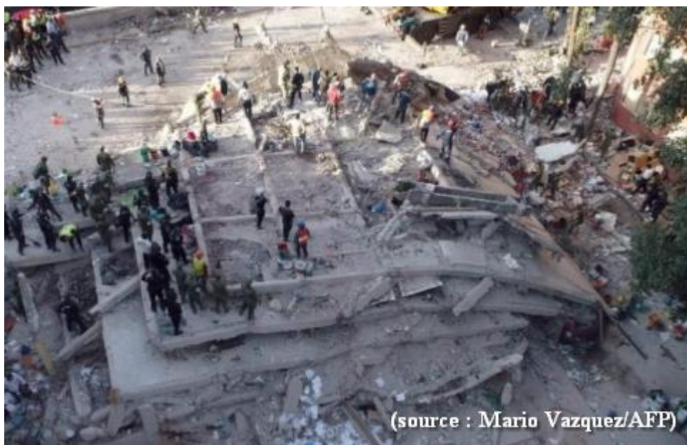
Figure I-21 : Immeuble effondré à Mexico suite aux secousses du séisme du 19 septembre 2017.
