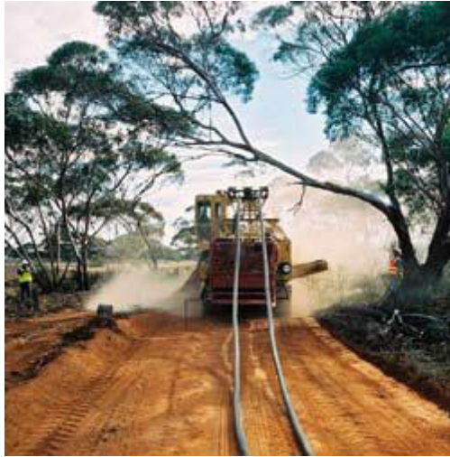
Figure. 1.7 – Le projet Murraylink, en Australie, repose sur une méthode simple et très efficace utilisant des matériaux issus de l'industrie de la fibre de verre.
