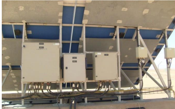
Figure 2.6 : Boîtes de protection et de distribution
