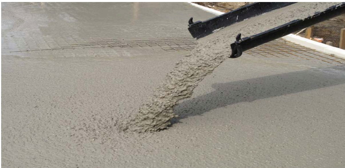
Figure 1: Mélange de béton
