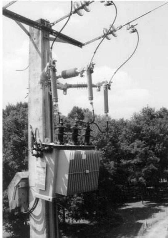
**Figure III.7:** Parafoudre HTA à oxyde de zinc et enveloppe synthétique protégeant un transformateur MT/BT [6].
