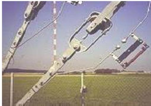
**Figure I.13:** Photo d'un éclateur à air [1].
