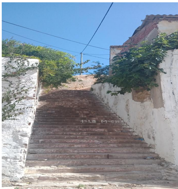
Figure III.4 : la rue escalier menant à la mairie
