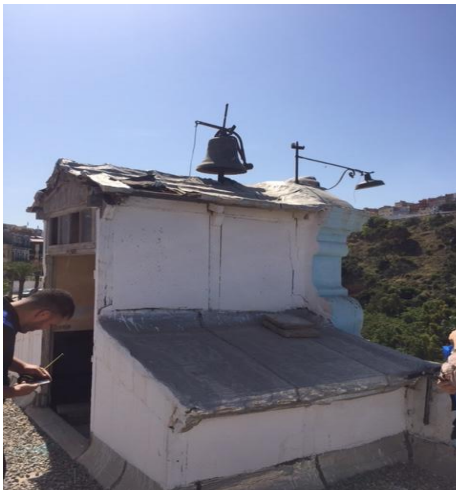
Figure III.16 : Cave d'horloge avec charpente en bois surplombée d'un clocher
