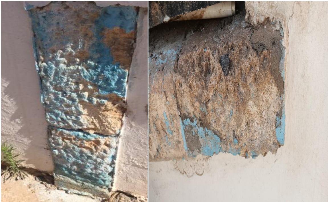
Figure III.24 : l'alvéolisation de la pierre
