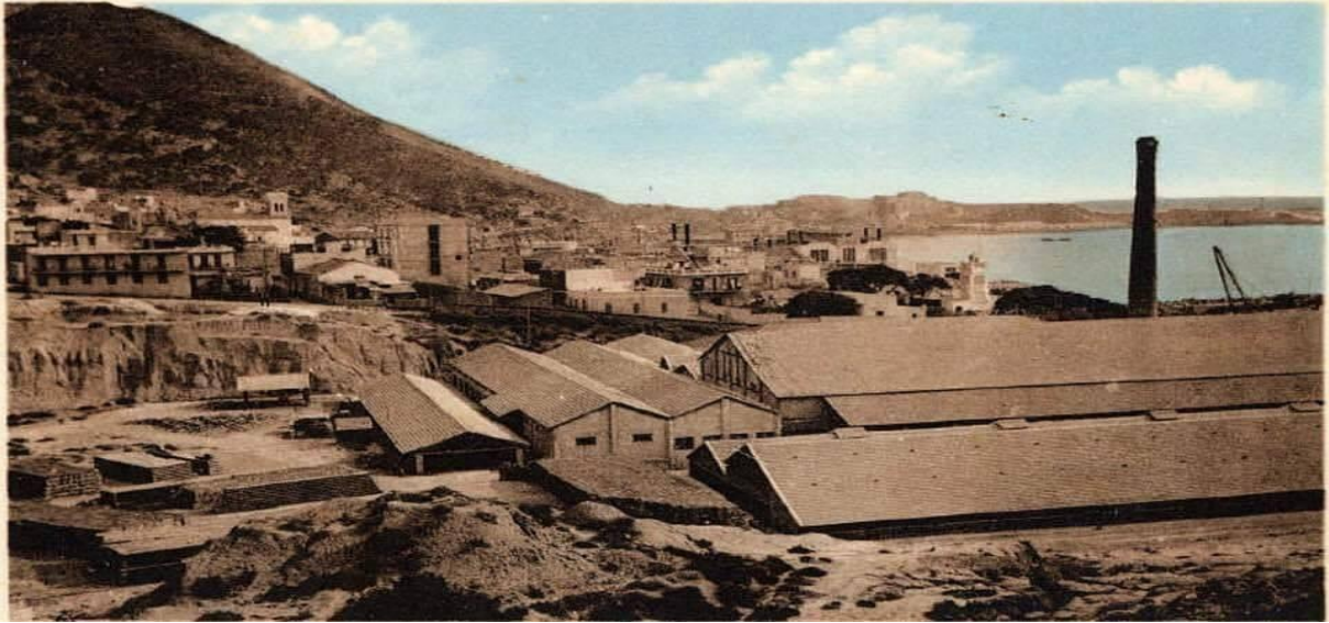
Figure III.20 : Briqueterie SABO à Mers El Kabîr
