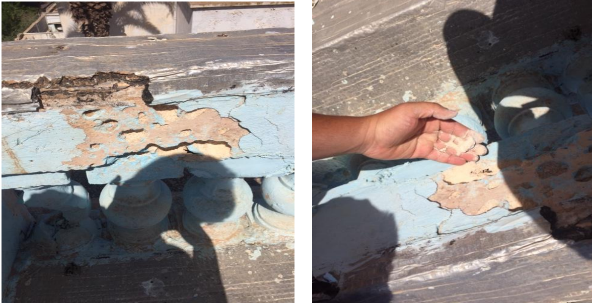
Figure III.23 : La pulvérulence de la pierre
