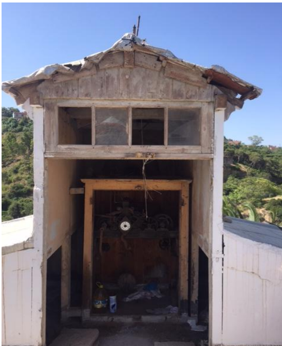
Figure III.17 : Cave d'horloge avec charpente en bois
