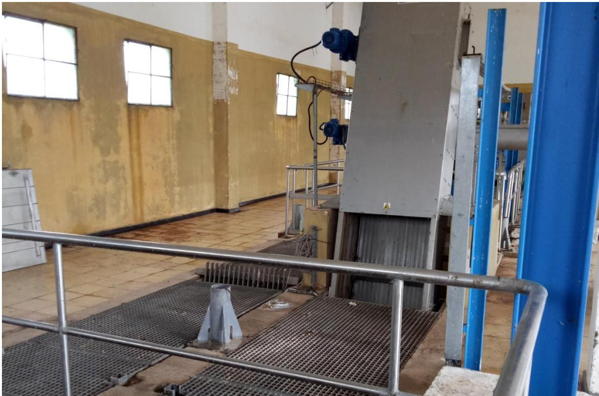
**Figure II.19.** La grille mécanique grossière.
