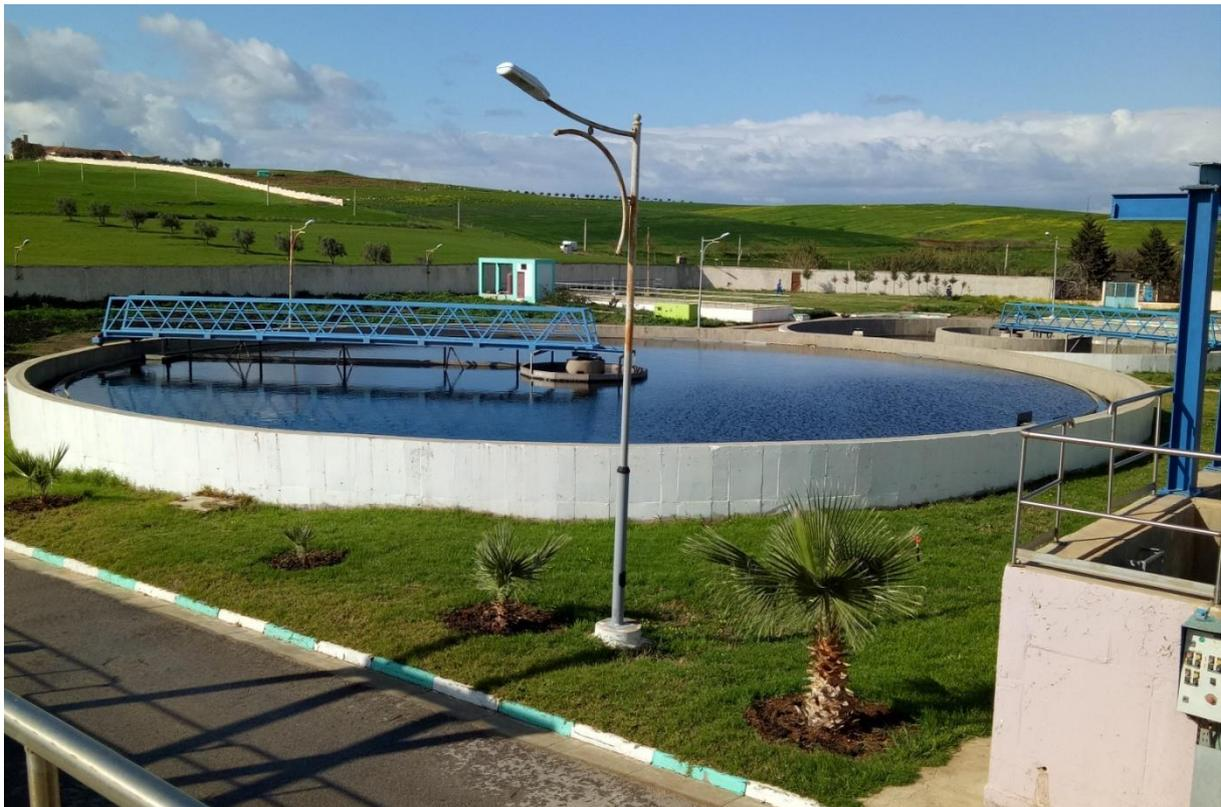
Figure II.23. Le décanteur secondaire.
