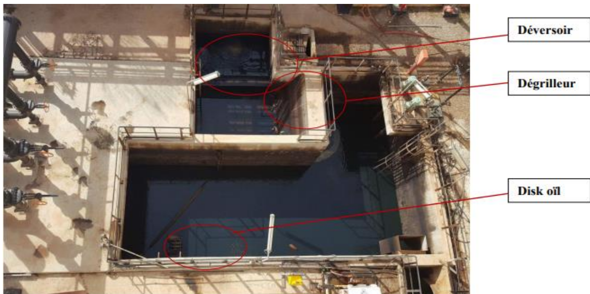
Figure III.2 : Déversoir et bassin d'orage.
