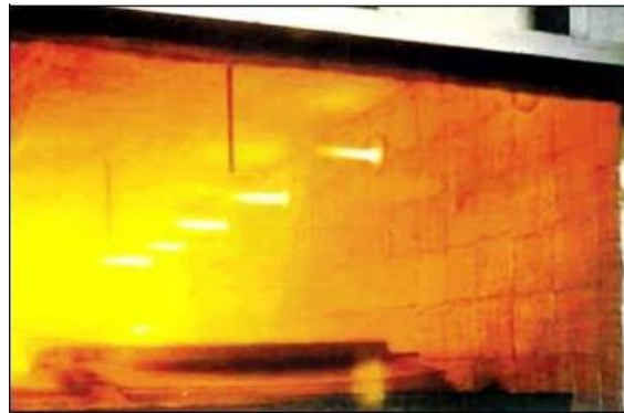
Figure 31 : Une rangée de brûleurs à haute vitesse d'un four tunnel
