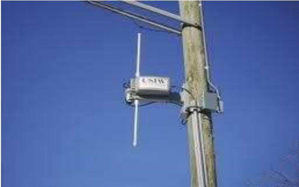
**Figure 5 :** Antenne dipolaire. [5]
