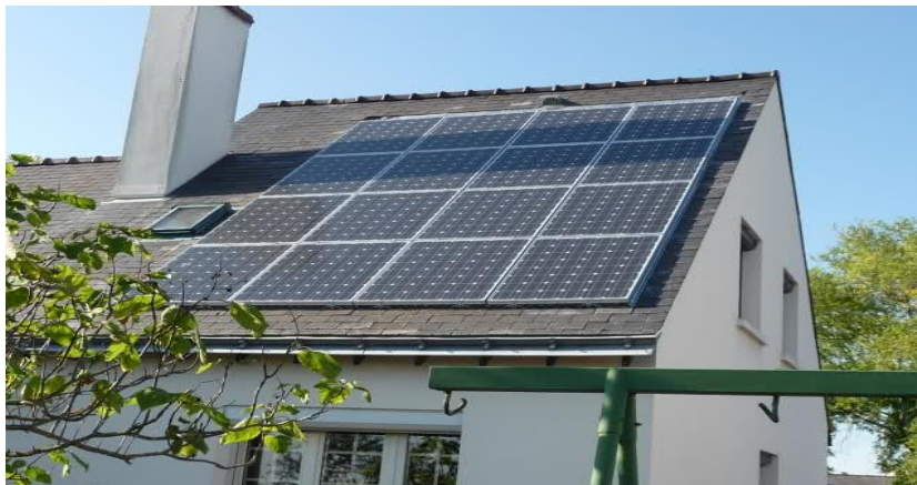
Figure I.18 : Effet d'ombre sur le panneau solaire
