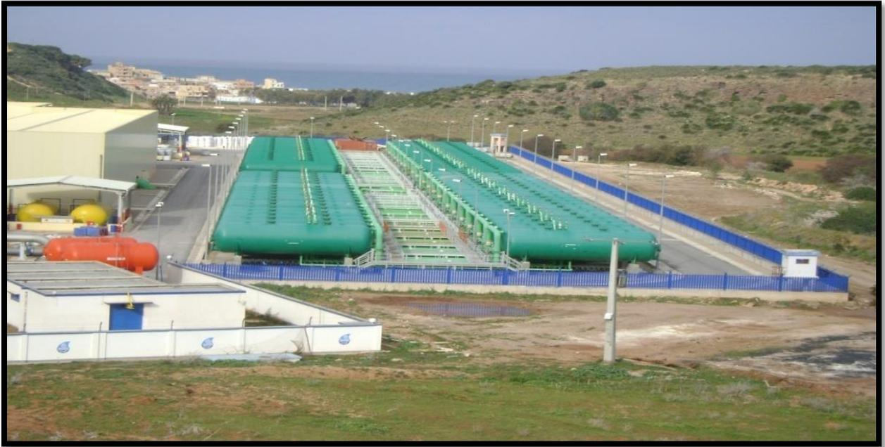
**Figure III.8 :** zone des filtres à sable et à anthracite de la SDEM de Béni Saf
