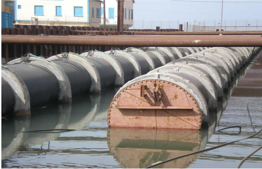
Figure III.3 : Tuyaux de captage de l'eau de mer pour la station (PEHD)
