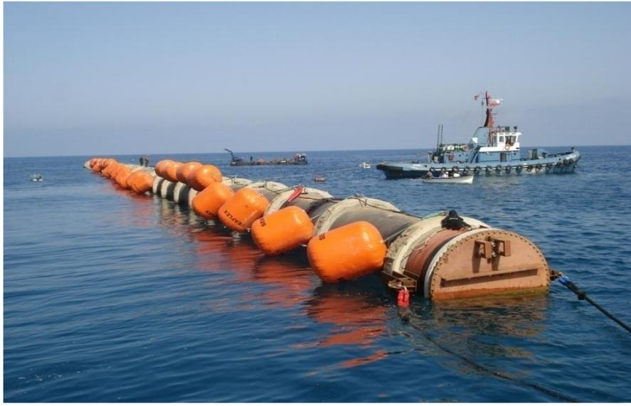
**Figure III.5 :** Tuyaux de captage de l'eau de mer pour la station (PEHD)
