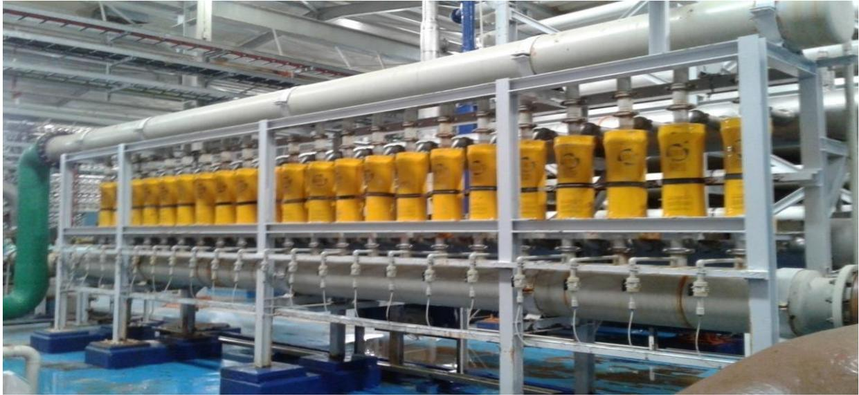
Figure III.12 : les récuperateurs d'énergie (ERI) d'un module d'OI de la SDEM
