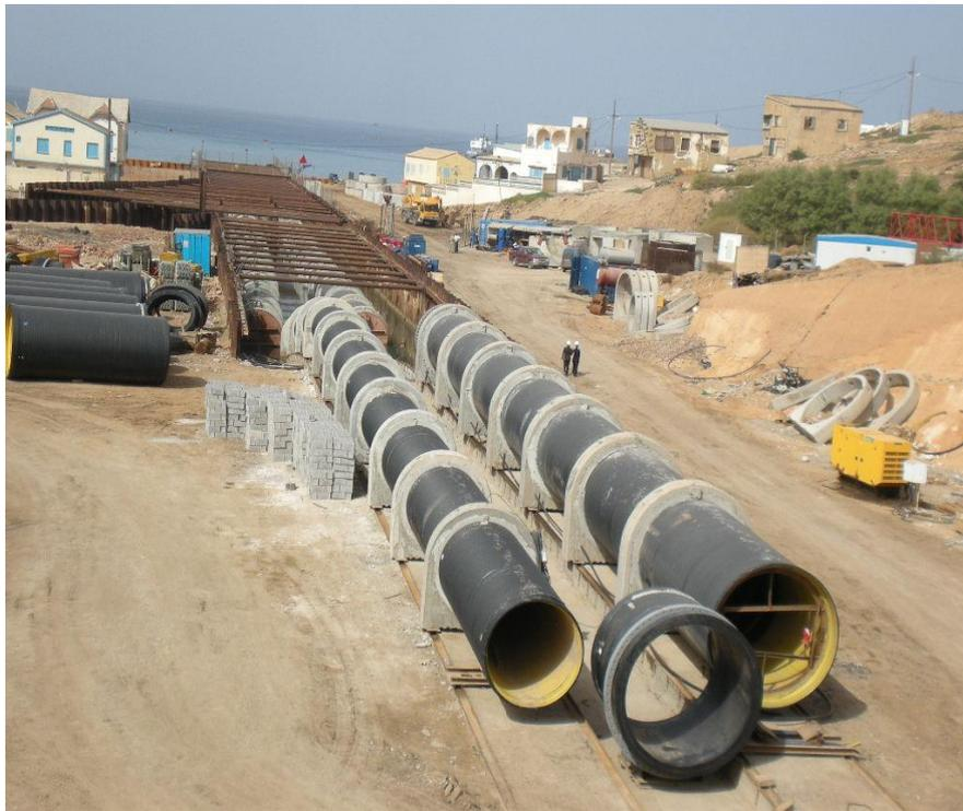
Figure III.4 : Tuyaux de captage de l'eau de mer pour la station (PEHD)
